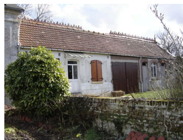
Vue des annexes. Phot. Inès Guérin IVR22_20058005261NUCA
