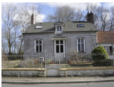
Vue détaillée de la maison. Phot. Inès Guérin IVR22_20058005260NUCA
