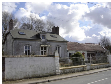
Vue générale. Phot. Inès Guérin IVR22_20058005259NUCA
