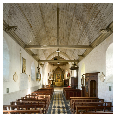
Intérieur, vue de la nef depuis le clocher. Phot. Thierry Lefébure IVR32_20238000740NUCA
