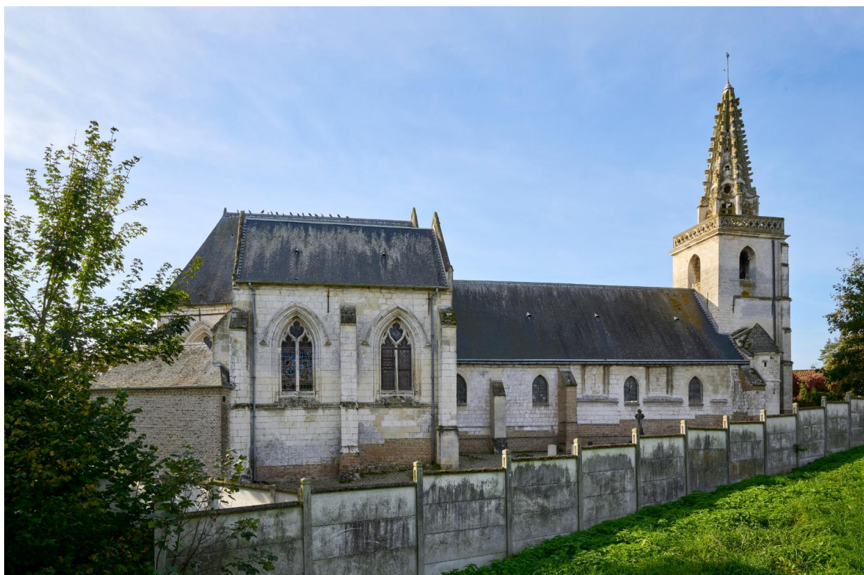
Vue d'ensemble de l'église, depuis le nord.
