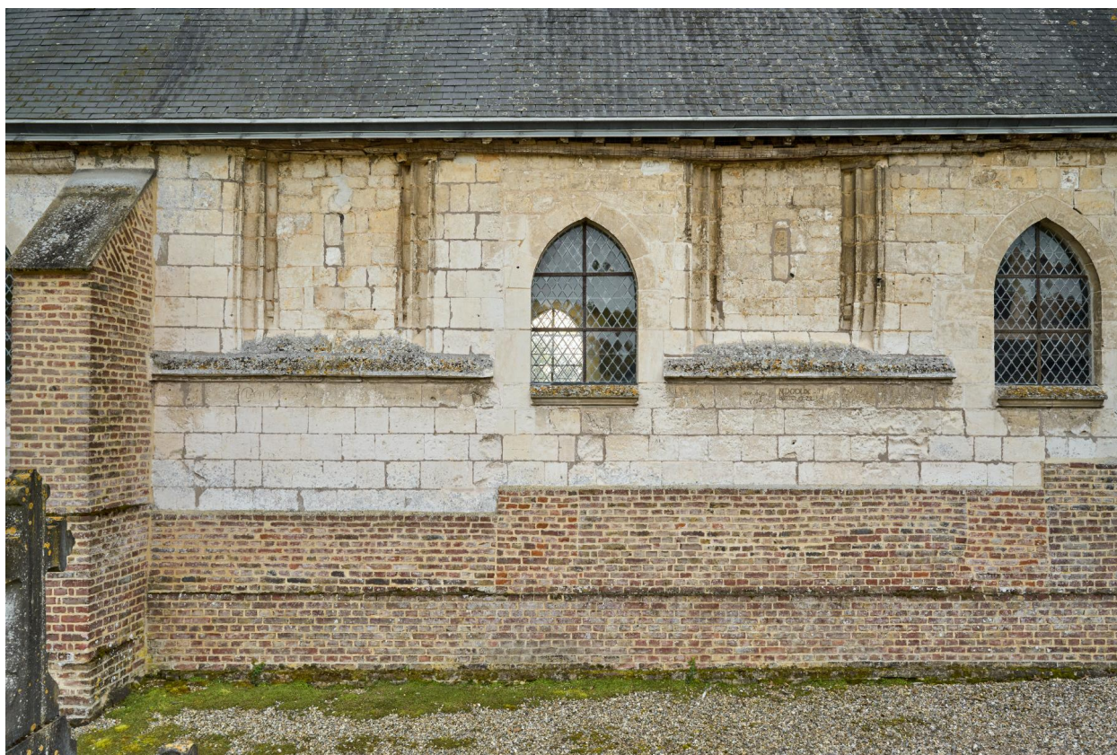
Détail de l'élévation nord.
