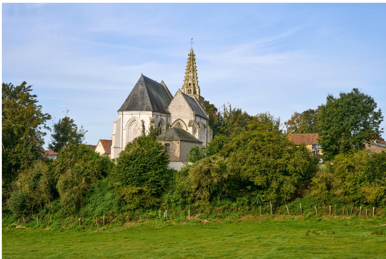
Vue du chevet, de la chapelle et de la sacristie, depuis l'est.
