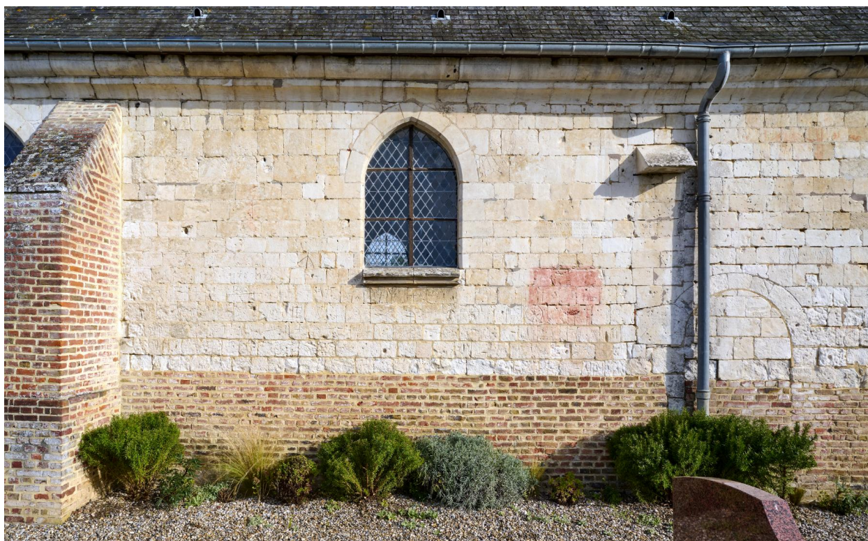
Détail de l'élévation sud.
