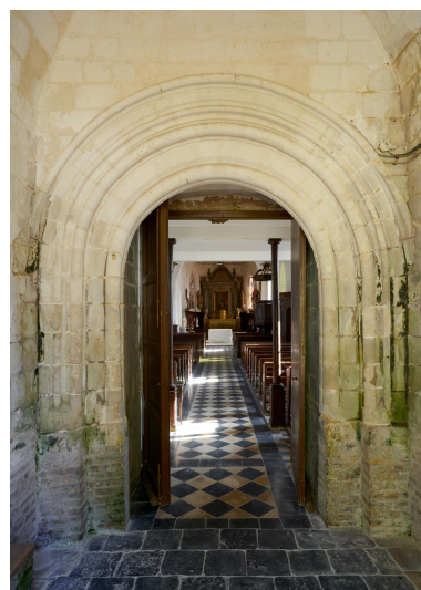
Intérieur, portail roman entre le clocher et la nef. Phot. Thierry Lefébure IVR32_20238000737NUCA
