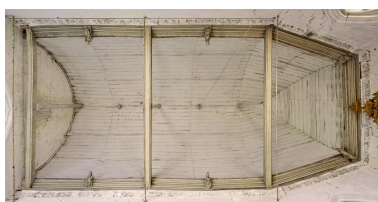
Intérieur, vue de la voûte du chœur. Phot. Thierry Lefébure IVR32_20238000753NUCA
