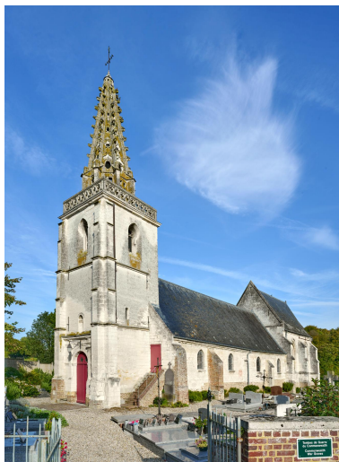
Vue du clocher, depuis le sud-ouest. Phot. Thierry Lefébure IVR32_20238000715NUCA
