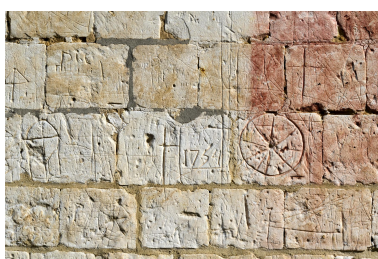
Détail des inscriptions, élévation sud de la nef. Phot. Thierry Lefébure IVR32_20238000723NUCA
