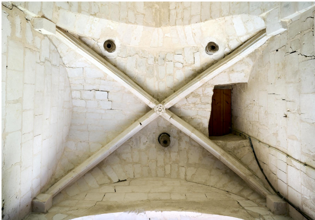
Intérieur, voûte du clocher.
