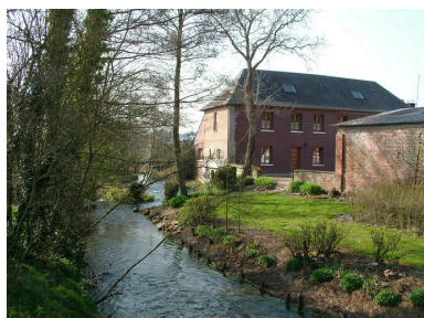
Vue générale des bâtiments de l'ancien moulin depuis la Nièvre. Phot. Frédéric Fournis IVR22_20098005084NUCA
