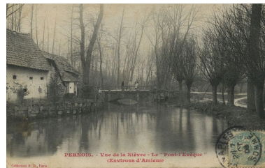
Vue de la Nièvre, du Pont- l'Évêque et des dépendances du moulin, avant 1906 (coll. part.). Phot. Monnehay-Vulliet Marie-Laure IVR22_20098000352NUCA
