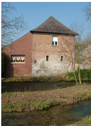
Mur de croupe de l'ancien moulin portant la trace de l'ancienne roue hydraulique. Phot. Frédéric Fournis IVR22_20098005425NUCA
