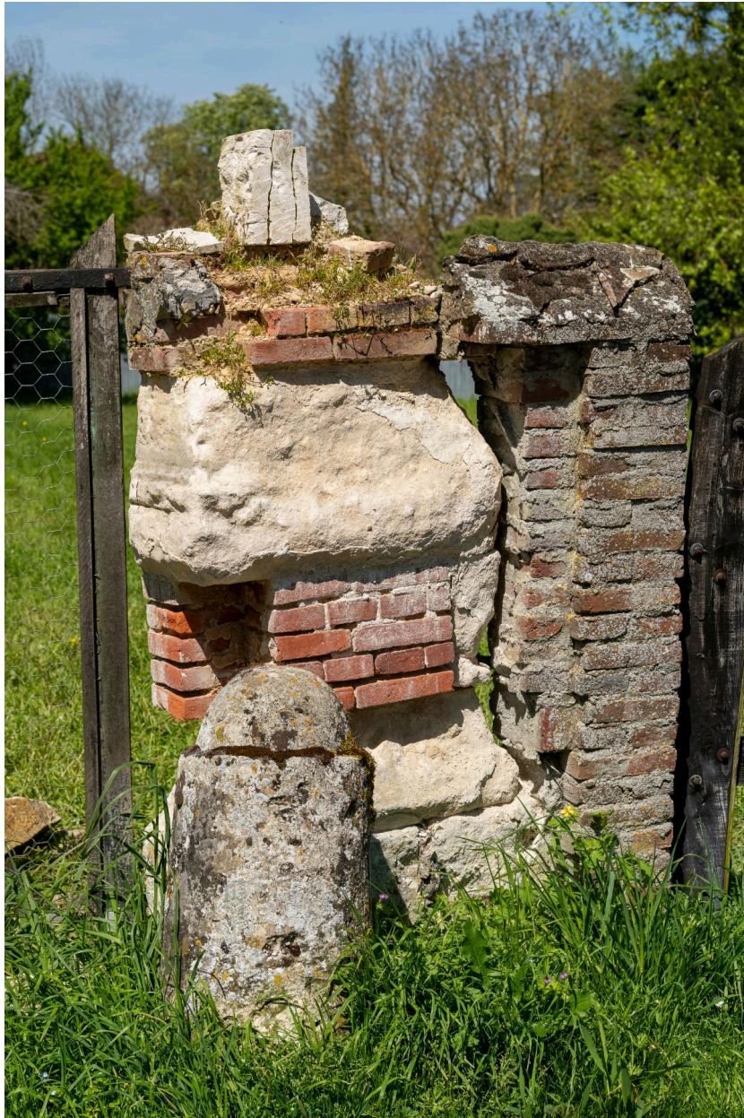
Ancien portail du château : détail du pilier droit.
