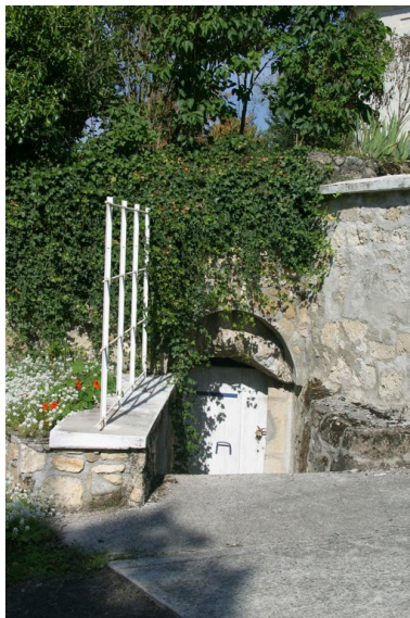
Vue de l'entrée de la cave donnant sur la rue.
