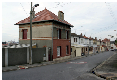
Vue d'ensemble de la cité, rue d'Amiens. Phot. Frédéric Pillet IVR22_20070205033NUCA
