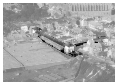
Vue aérienne de la cité vers 1950-1960 (AD Aisne). Phot. Pillet Frédéric IVR22_20060205418NUCAB
