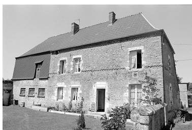
Élévation antérieure du logis. Phot. Xavier-Philippe Guiochon IVR22_19980202735Z
