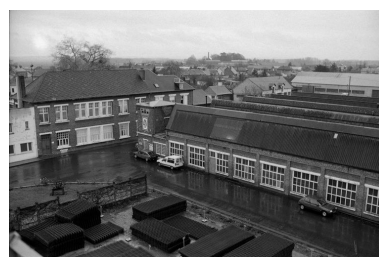
Atelier de fabrication et bureau : flanc nord-est. Phot. Francis Dubuc IVR22_19908001412Z
