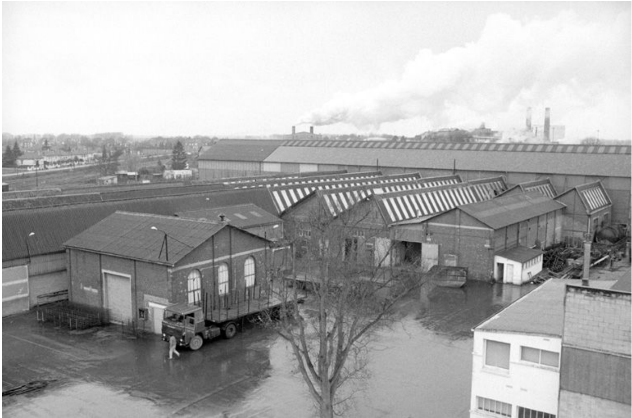
Atelier de fabrication : vue générale.
