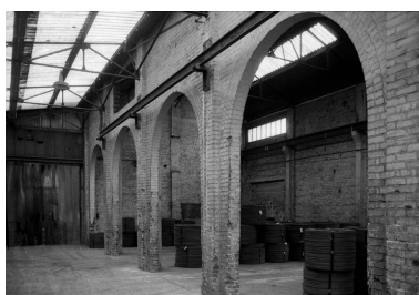
Atelier de fabrication : vue intérieure. Phot. Francis Dubuc IVR22_19908001402Z
