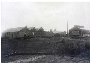
Vue d'ensemble des bâtiments de la tréfilerie en cours de construction, vers 1920 (AD Somme ; 10 R 625). Phot. Fournier Bertrand (reproduction) IVR22_20158006218NUCA
