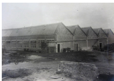
Les ateliers en shed de la tréfilerie, vers 1922 (AD Somme ; 10 R 625). Phot. Fournier Bertrand (reproduction) IVR22_20158006217NUCA
