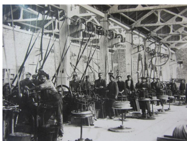
Intérieur de l'atelier de tréfilerie, vers 1925 (AD Somme ; 10 R 625). Phot. Fournier Bertrand (reproduction) IVR22_20158006219NUCA
