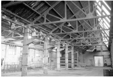
Atelier de fabrication : vue intérieure. Phot. Francis Dubuc IVR22_19908001401Z
