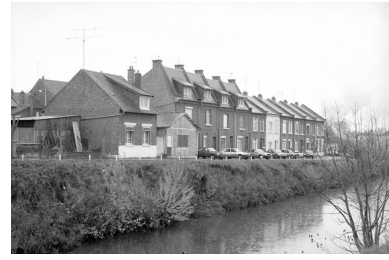
Logement d'ouvriers, rue de la Clouterie, élévation antérieure. Phot. Francis Dubuc IVR22_19908001416Z
