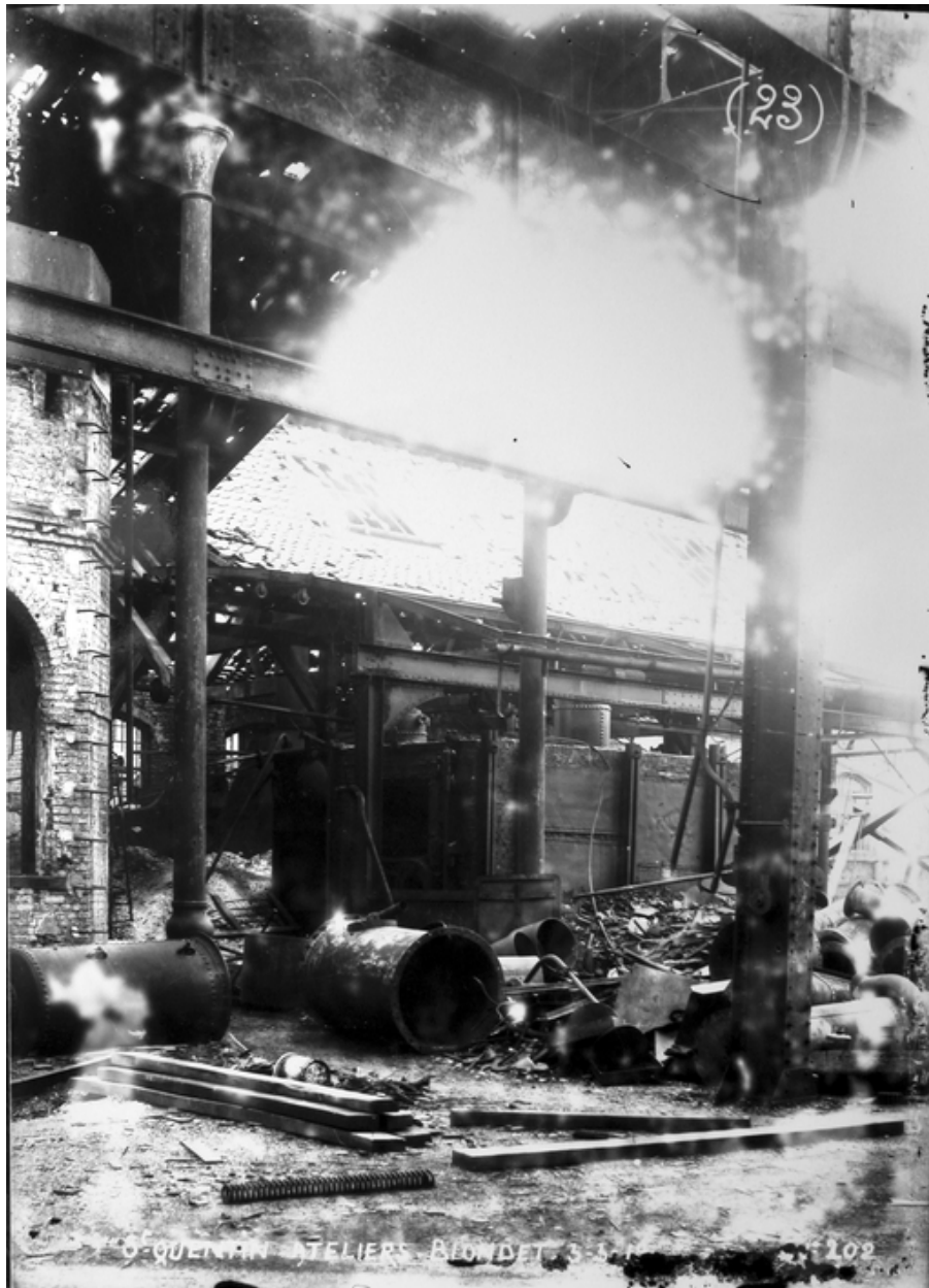
Les ateliers en ruine, 1919 (AD Aisne).
