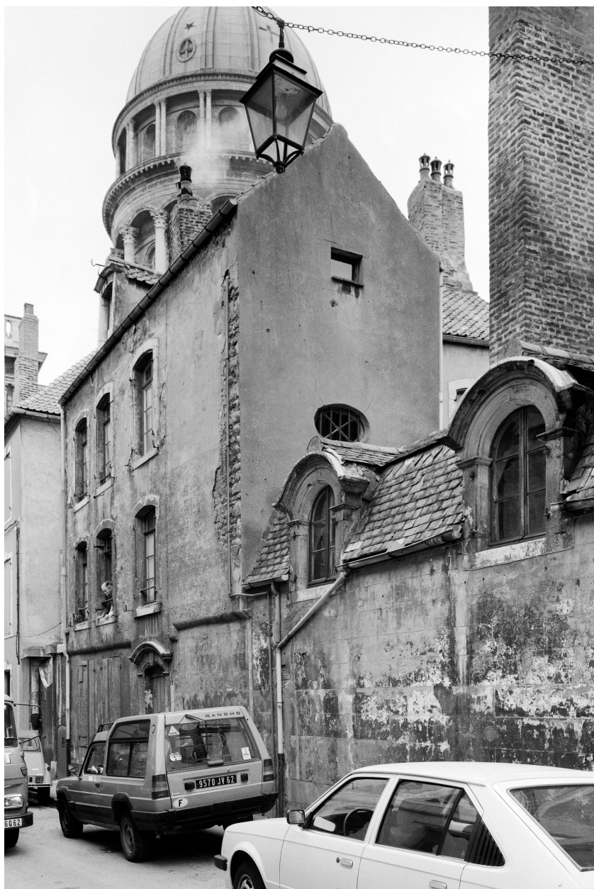
Vue d'angle sud-est avant restauration.
