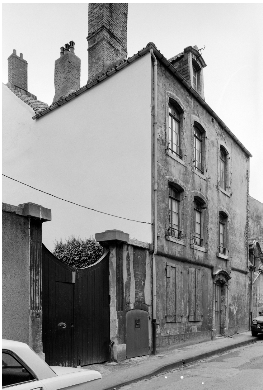
Vue d'angle sud-ouest avant restauration.
