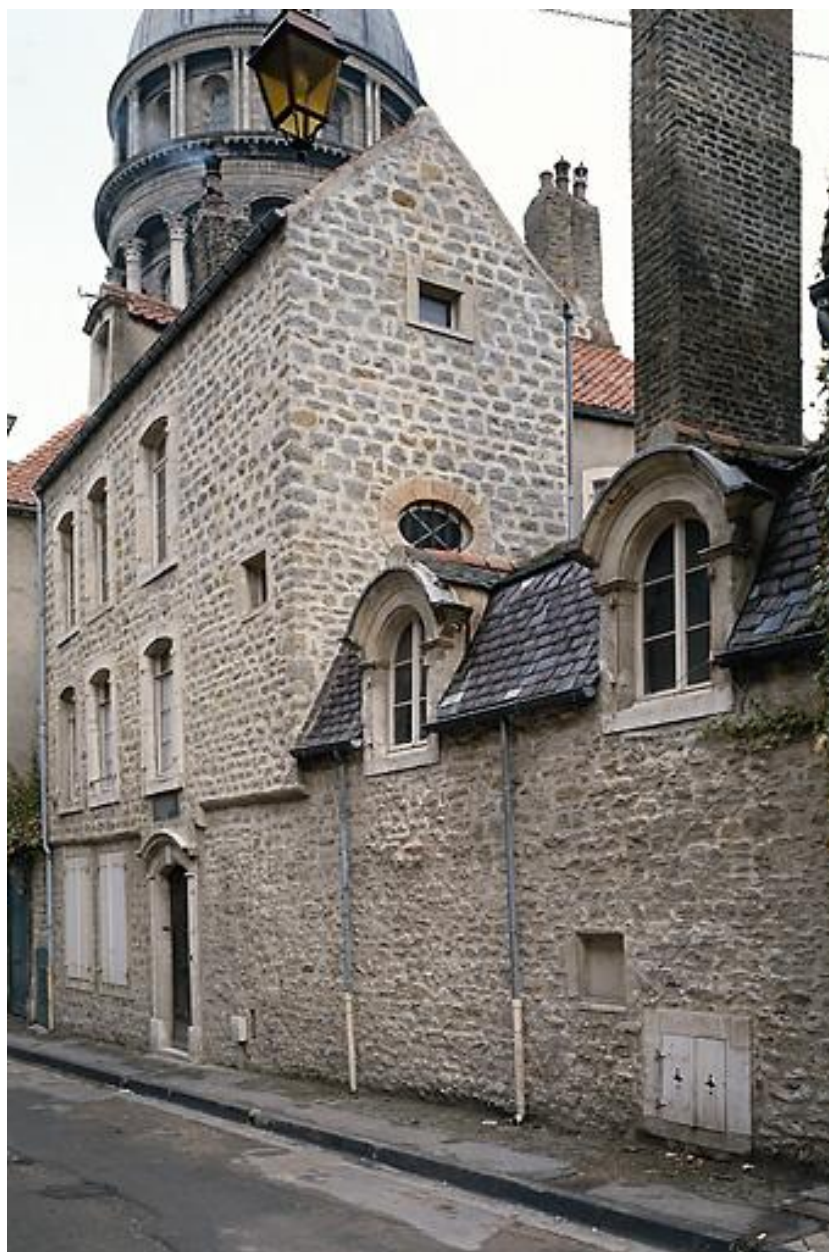
Vue d'angle sud-est après restauration.
