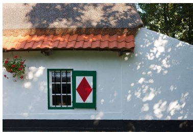
Détail de la façade sud. Fenêtre, chaume et tuiles. Phot. Hubert Bouvet IVR32_20115900720NUC4A
