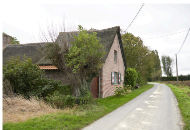
Détails du pignon ouest sur rue. Phot. Delphine Volto Jourdan IVR32_20255900444NUCA
