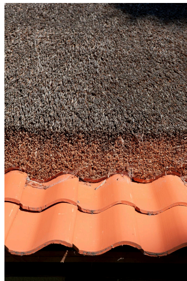
Détail de la toiture. Phot. Hubert Bouvet IVR32_20115900721NUC4A
