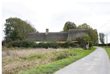
Chaumière dans son environnement direct. Phot. Delphine Volto Jourdan IVR32_20255900443NUCA
