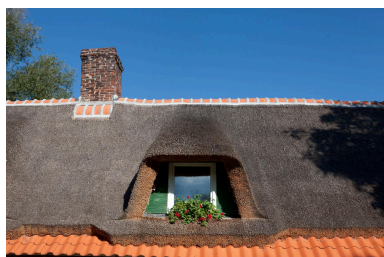
Lucarne ouvrant sur la toiture en chaume. Phot. Hubert Bouvet IVR32_20115900722NUC4A
