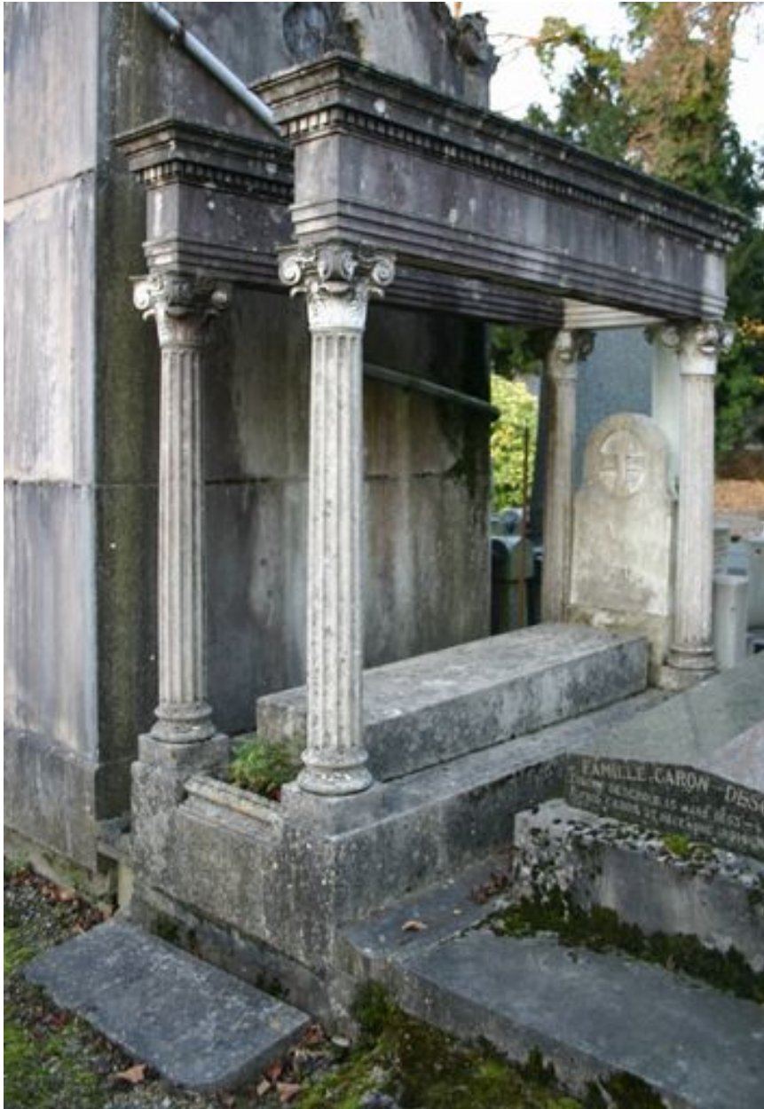
Vue générale, depuis le côté.
