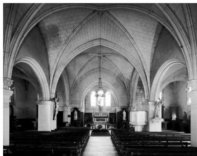
Vue intérieure vers le chœur. Phot. Jean-Michel Perrin IVR22_19846001368V
