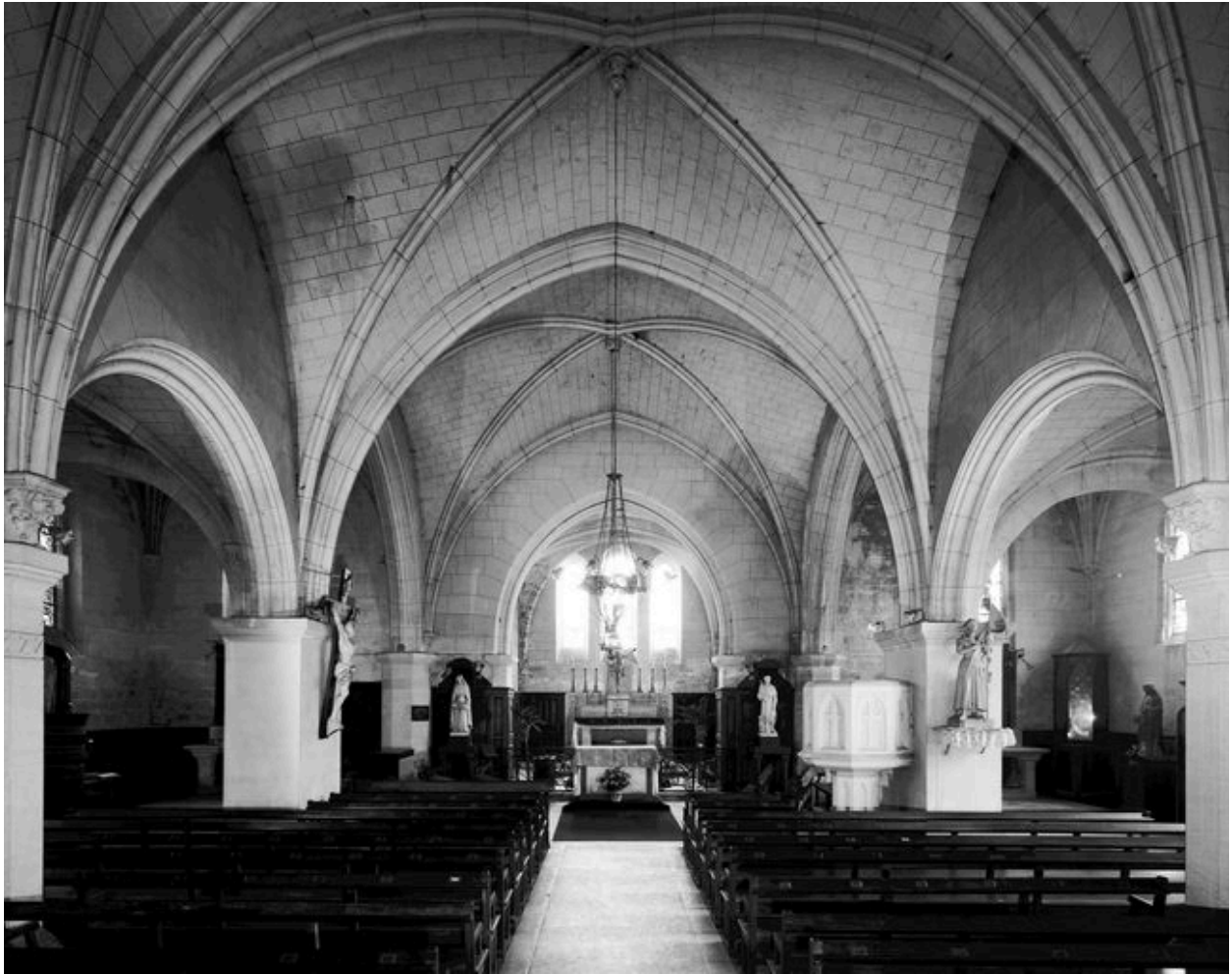
Vue intérieure vers le chœur.
