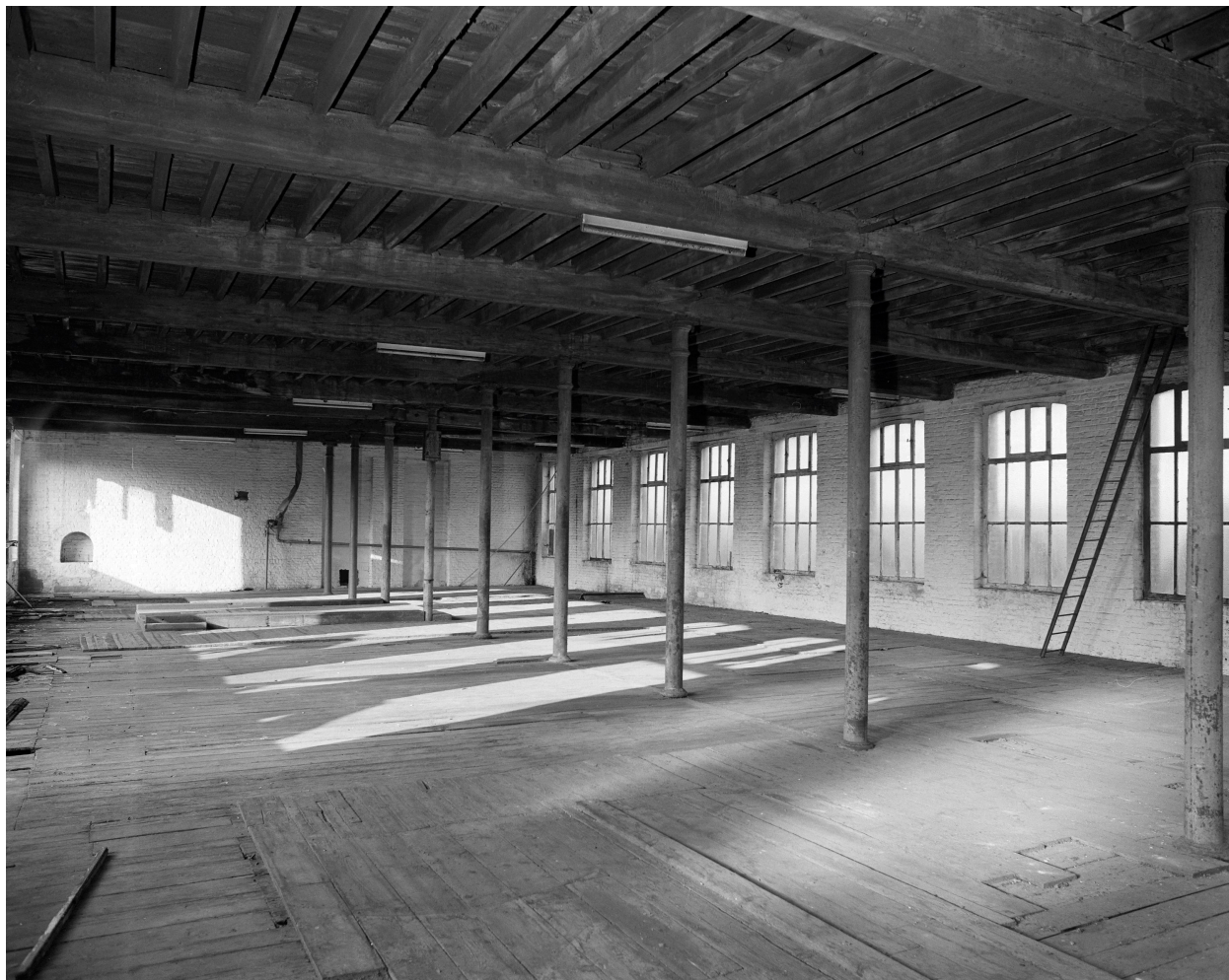
Atelier de fabrication, partie ancienne, premier étage.
