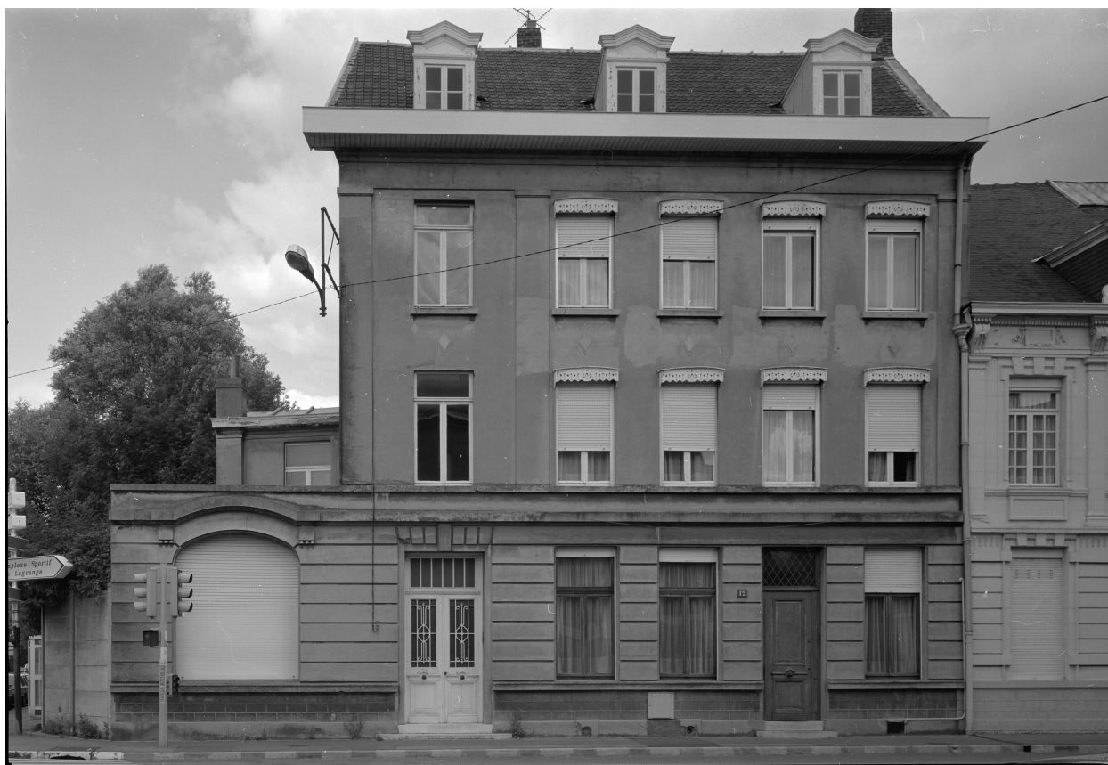
Anciens bureaux et portail d'entrée.
