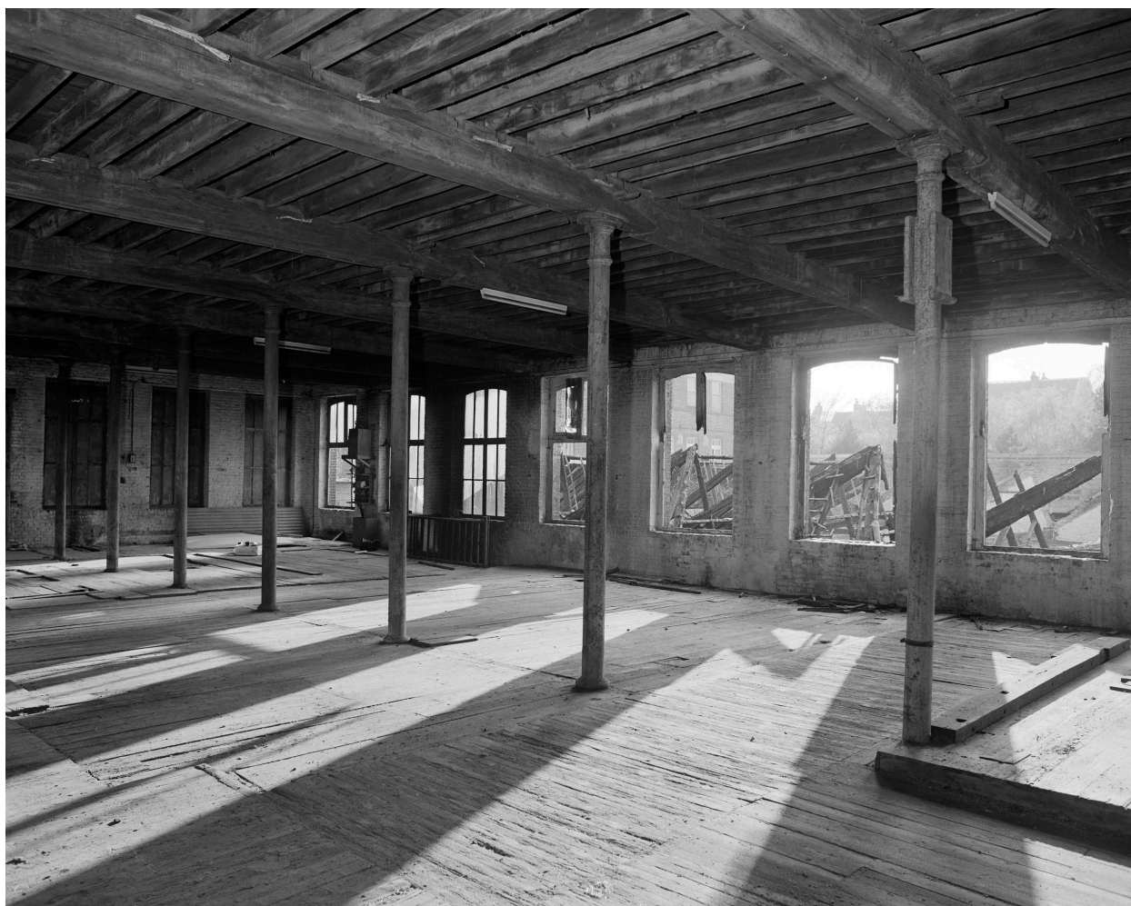
Atelier de fabrication, partie ancienne, premier étage.
