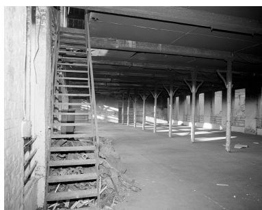
Atelier de fabrication, partie ancienne, rez-de-chaussée.
