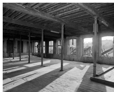
Atelier de fabrication, partie ancienne, premier étage.
