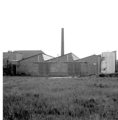
Atelier de fabrication, élévation avenue Aristide-Briand. Phot. Philippe Dapvril IVR31_19885900915X
