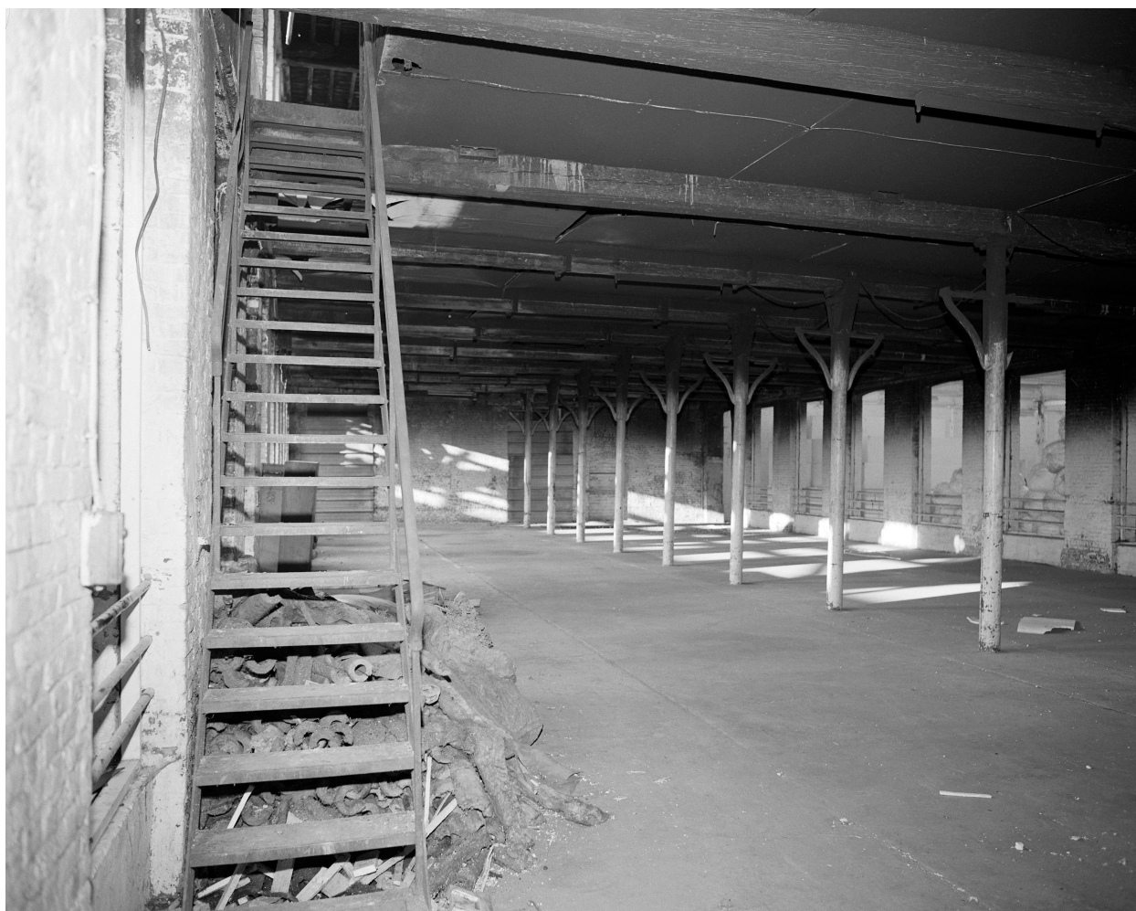
Atelier de fabrication, partie ancienne, rez-de-chaussée.
