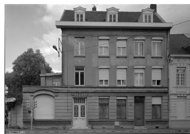
Anciens bureaux et portail d'entrée. Phot. Olivier Marlard IVR31_19885901420X
