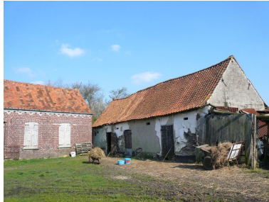
Vue de l'étable. Phot. Inès Guérin IVR22_20078005520NUCA
