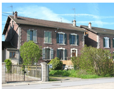
Maison à quatre logements de la cité Louis Blanc. Phot. Clarisse Lorieux IVR22_20086005131NUCA
