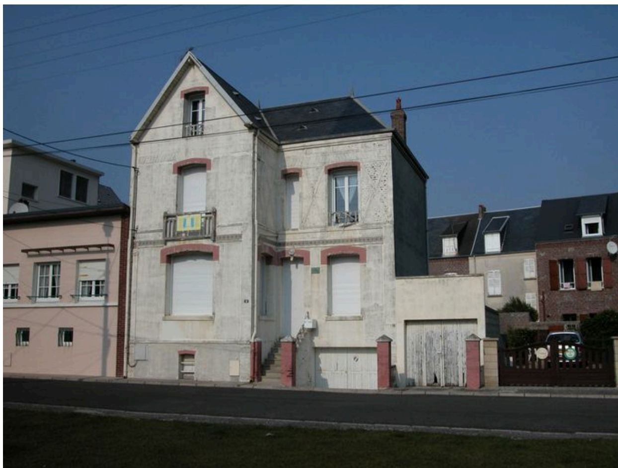
Aménagement tardif d'un garage en soubassement.
