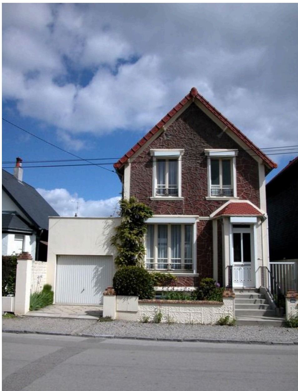
Enduit imitant des moellons de pierre, avenue Carnot (1988 BB 77).
