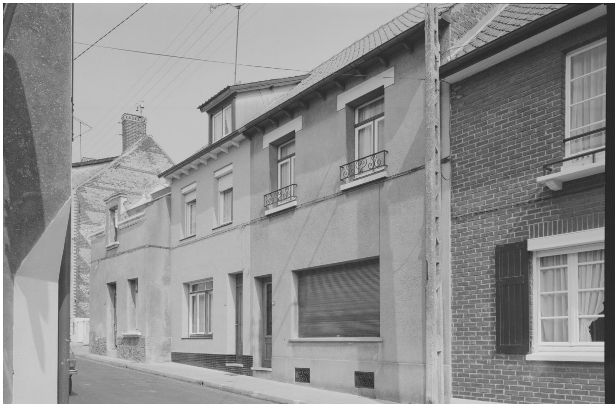
Vue générale de la maison du n°8 (avec la lucarne rampante) depuis la rue.
