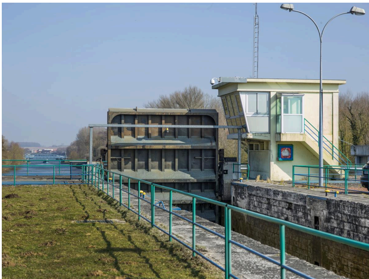
Poste de commande et porte levante.
