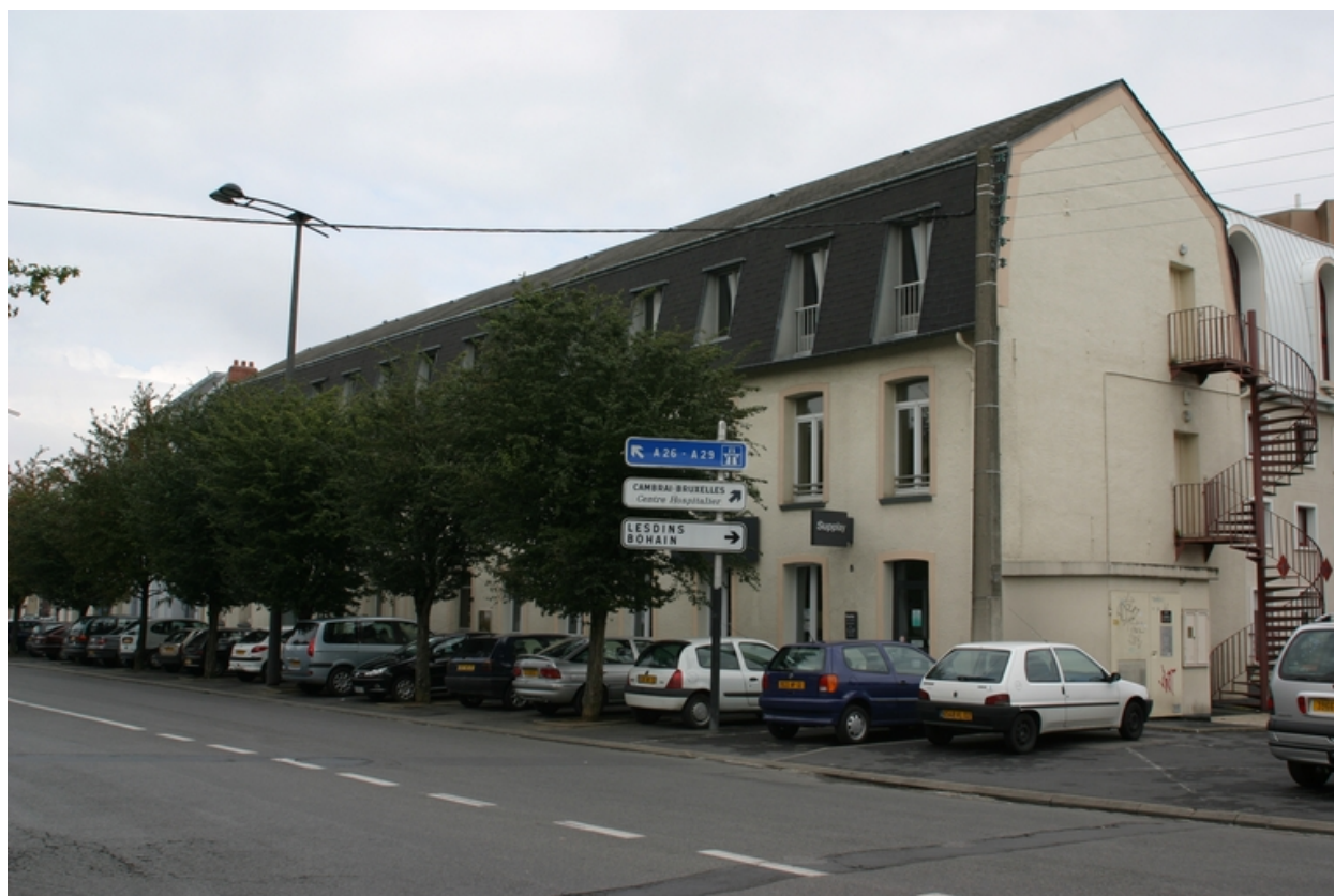
Façade antérieure de l'ancienne filature.
