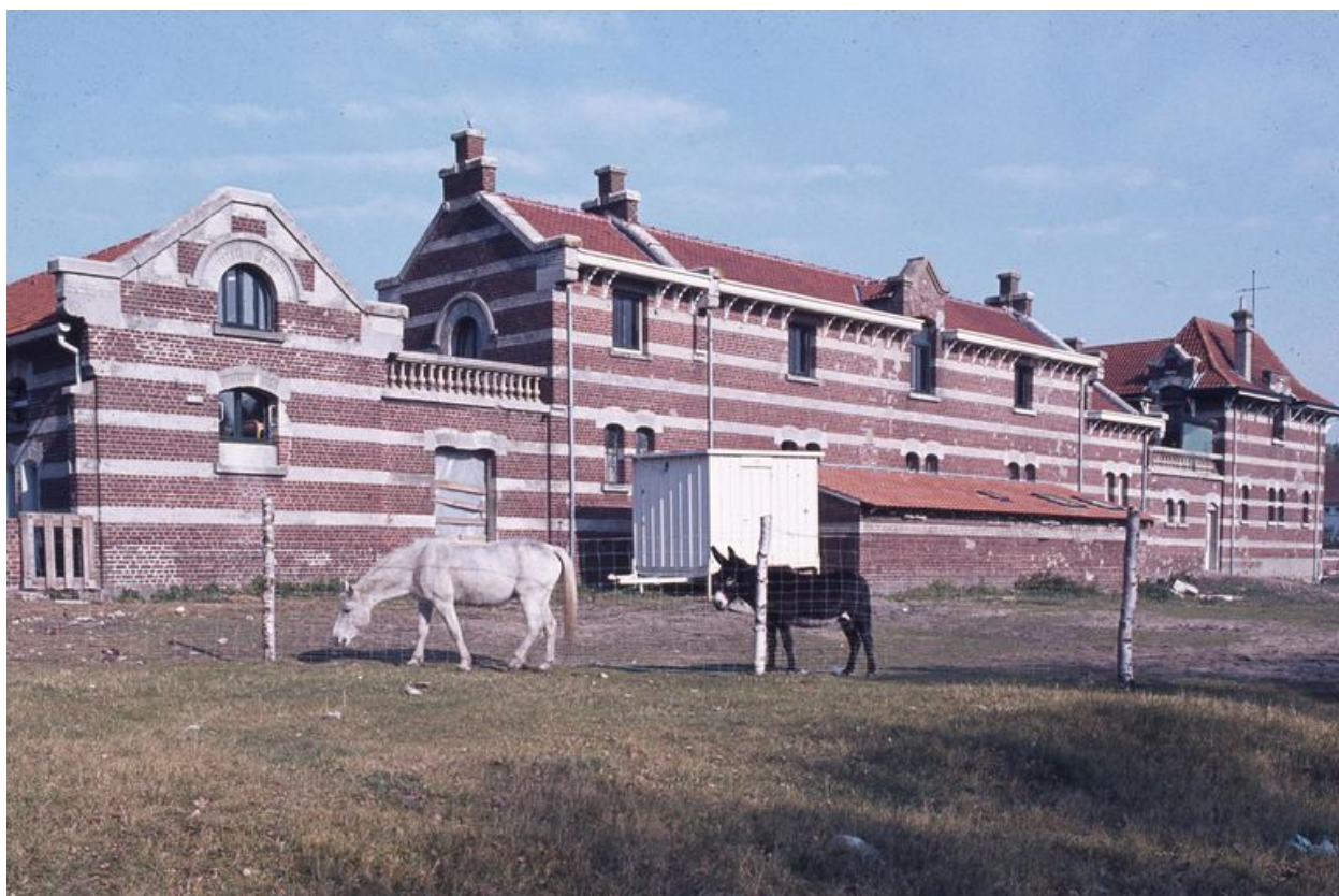
Ferme nord, bâtiments fermant la cour au sud, élévation extérieure, vue générale prise de trois quarts gauche.
