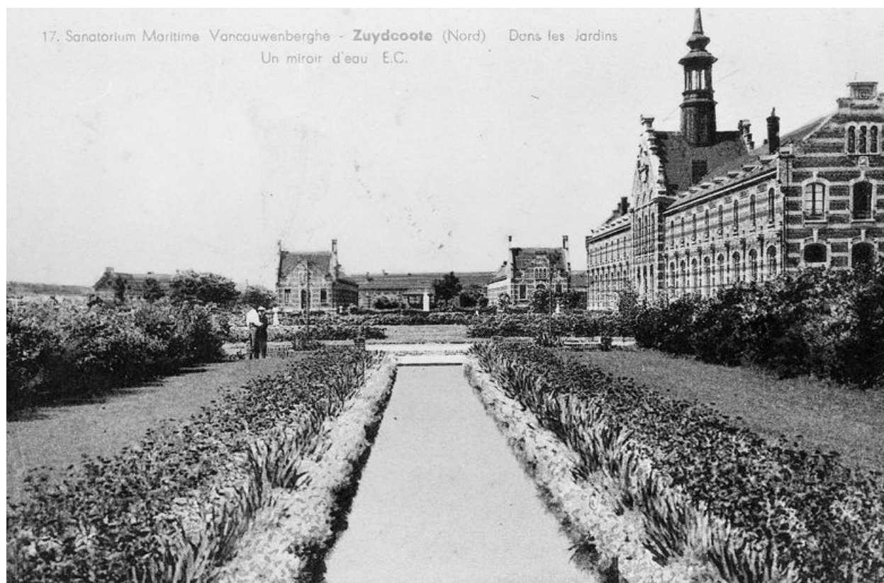
Bâtiment regroupant l'administration, les réfectoires et les services généraux, élévation antérieure, vue générale prise en enfilade depuis le côté droit, carte postale, début du 20e siècle (coll. part.).
