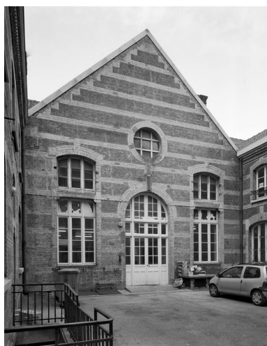
Bâtiment regroupant l'administration, les réfectoires et les services généraux, cour intérieure centrale, élévation du bâtiment, fermant la cour du côté nord, correspondant à la cuisine, vue générale. Phot. Philippe Dapvril IVR31_20035900234V
