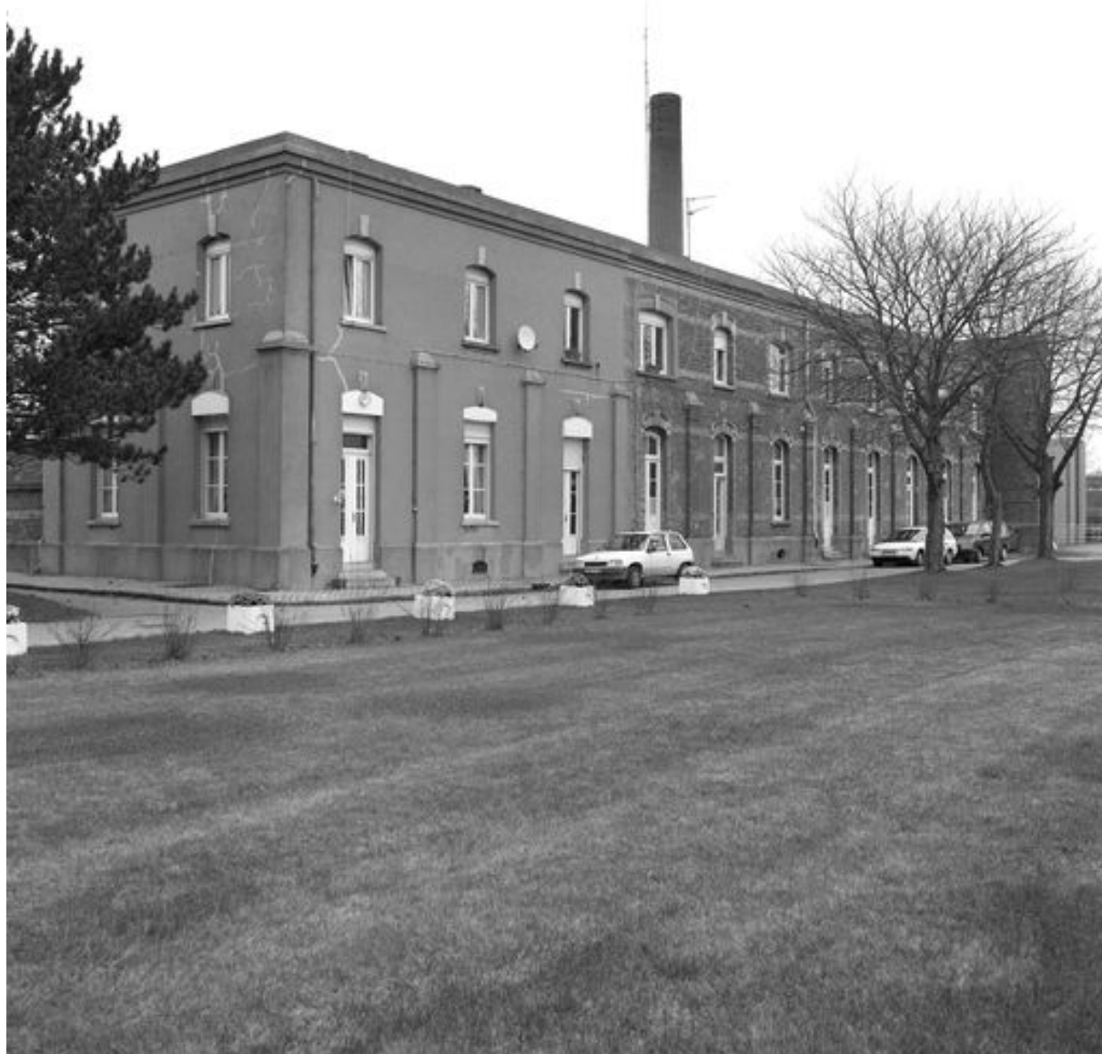
Bâtiment abritant la buanderie et les ateliers, avec des logements au 1er étage, élévation sud, vue de trois quarts gauche.
