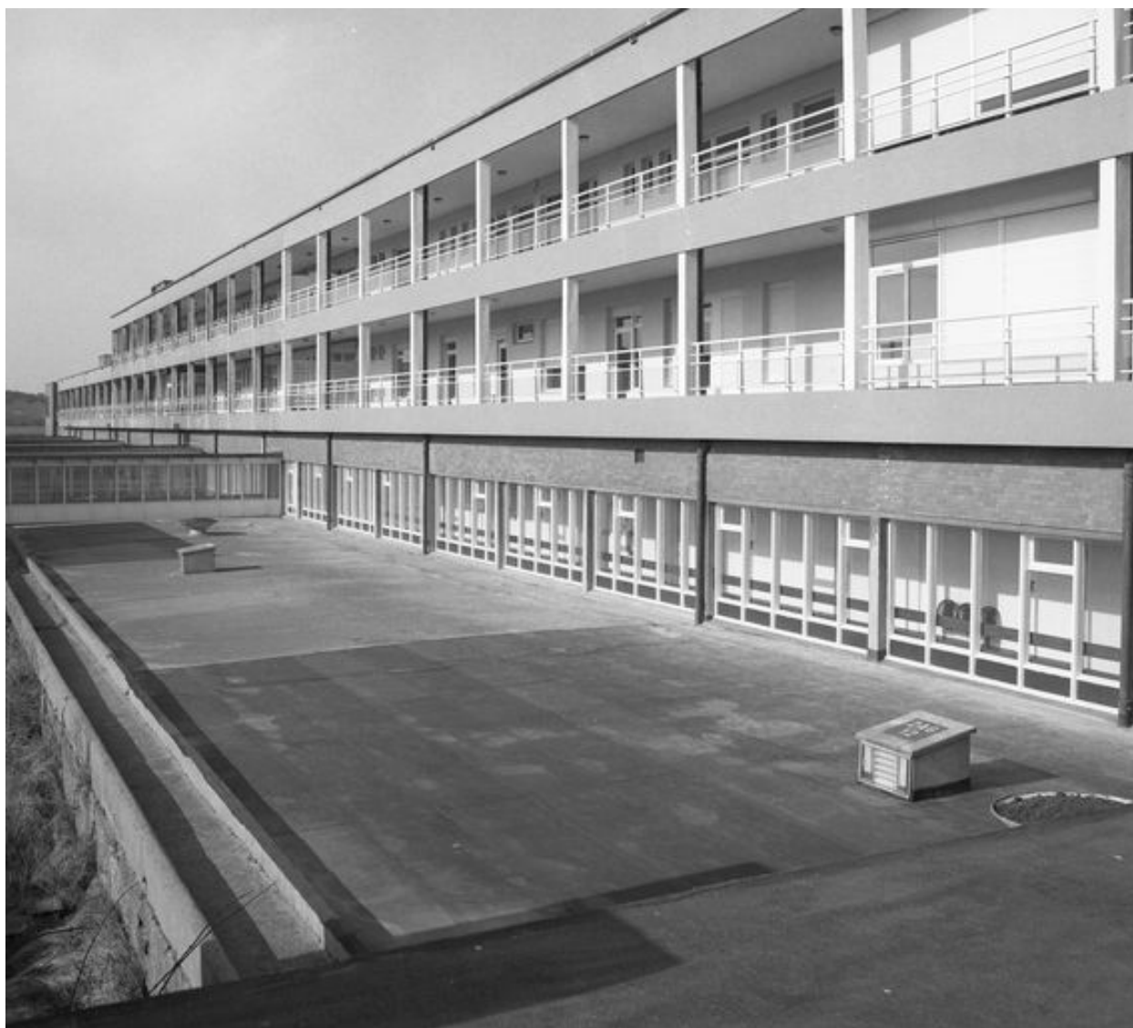
Bâtiment de 450 mètres de longueur dressé face à la mer, façade sud, détail de l'aile ouest avec ses galeries de cure superposées, vue en enfilade prise du côté droit.
