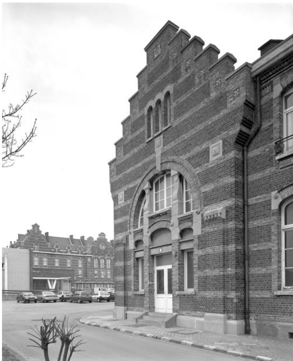
Bâtiment regroupant l'administration, les réfectoires et les services généraux, extrémité ouest de l'aile postérieure qui abrite les réfectoires et la cuisine, correspondant à l'entrée d'un des réfectoires, vue de trois quarts droit.
