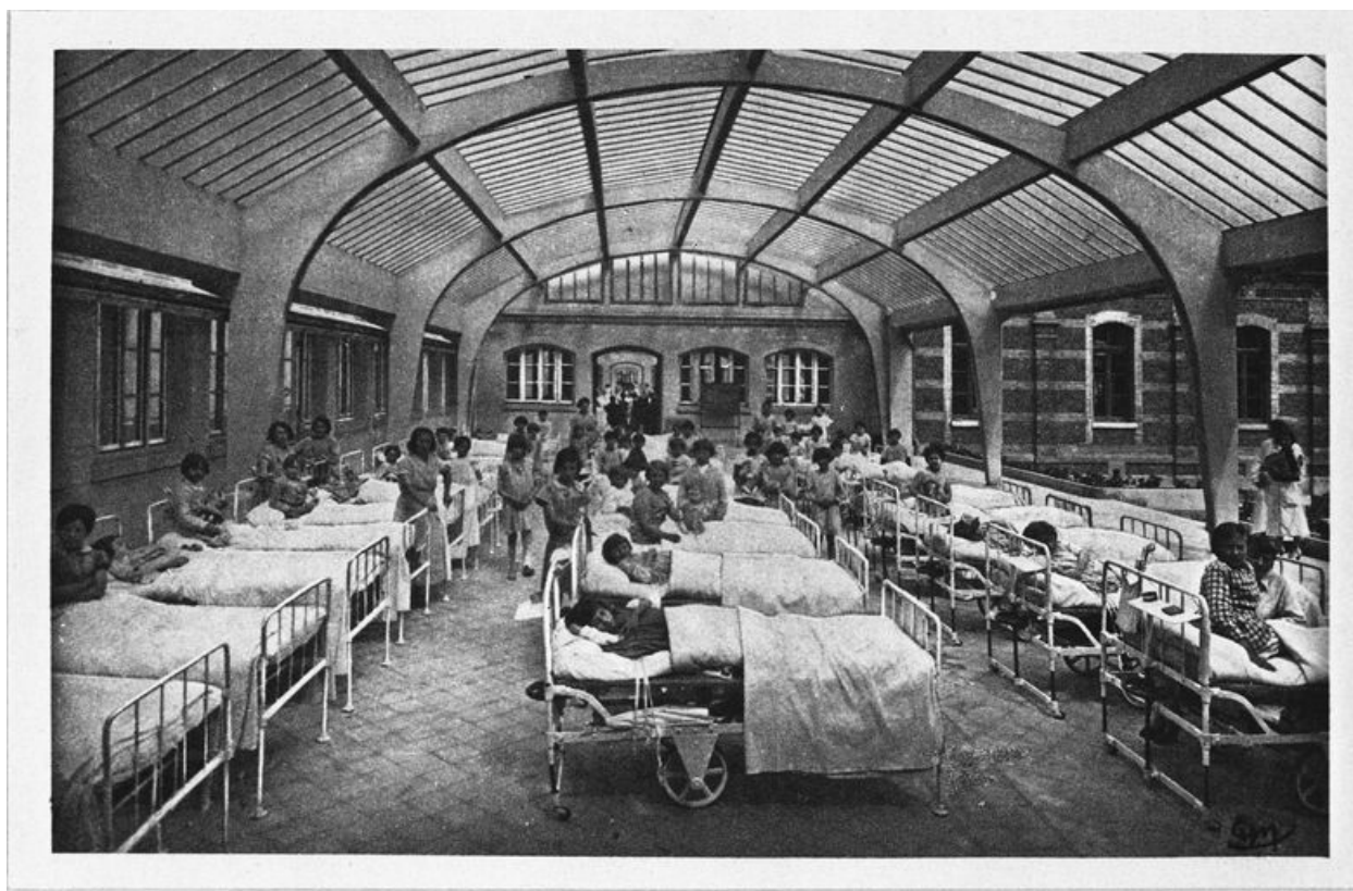
Un des solarium couverts ajoutés au-devant de la façade sud du bâtiment face à la mer, vue intérieure prise en enfilade, photographie ancienne, (archives de l'établissement).
