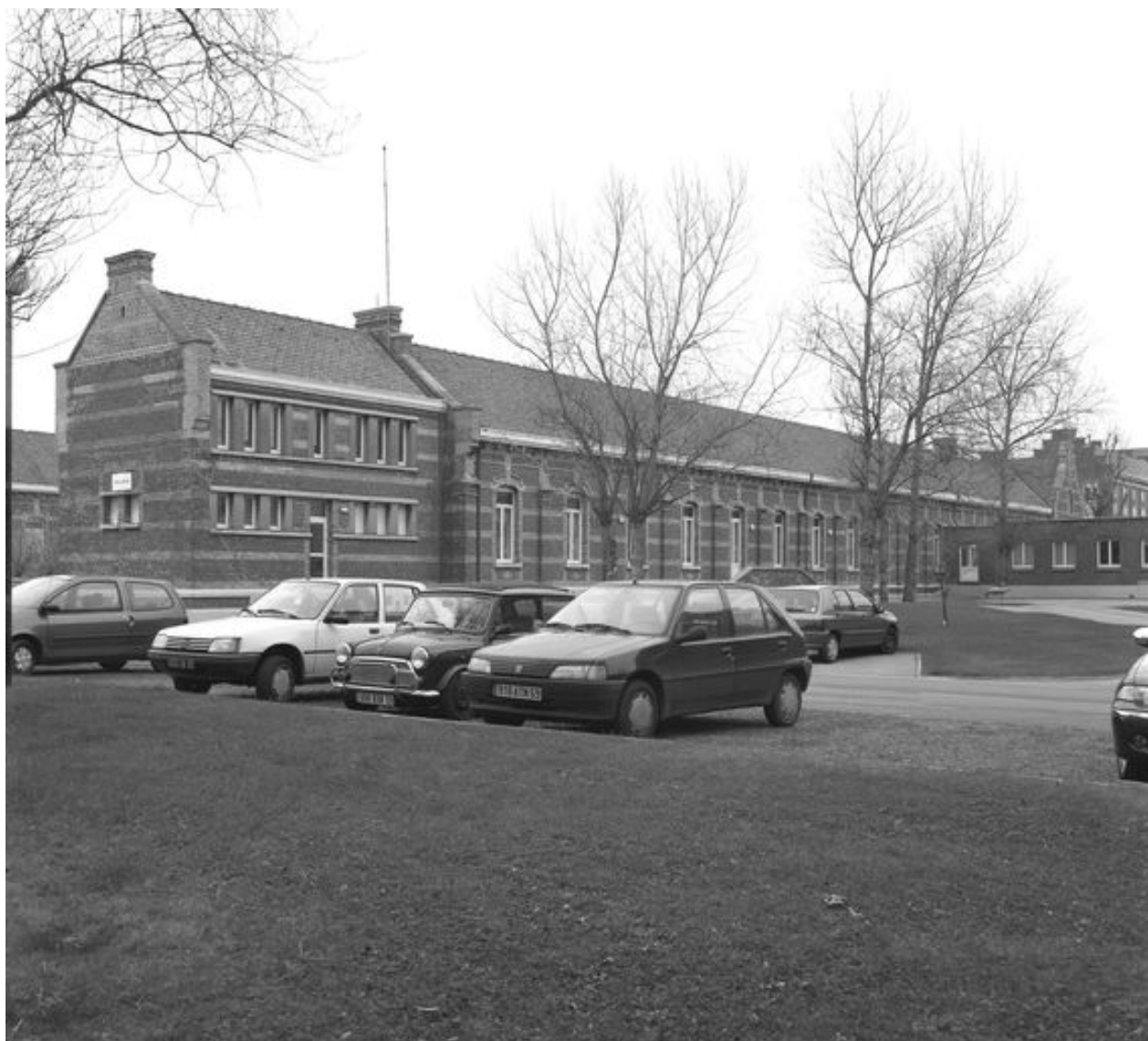
Pavillons des enfants valides, pavillon situé au centre de l'alignement du groupe ouest, désigné par la lettre E, élévation sud, vue de trois quarts gauche.
