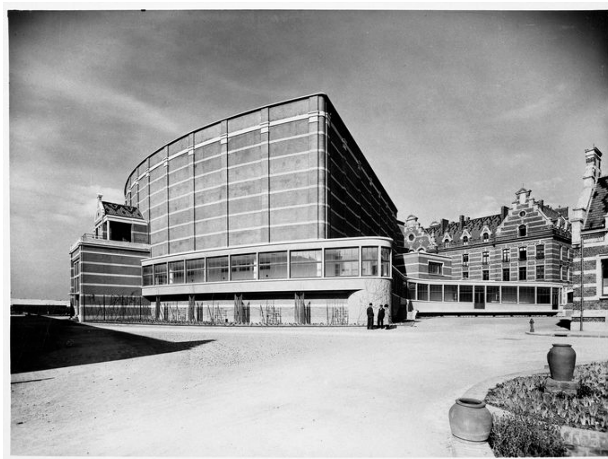
Salle des fêtes, élévation est, vue générale, photographie ancienne (archives de l'établissement).
