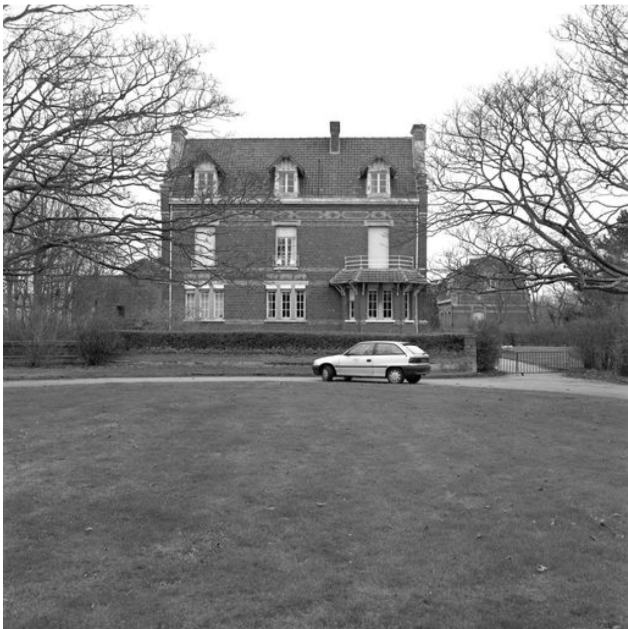
Habitation du directeur, élévation antérieure, vue générale prise de face.
