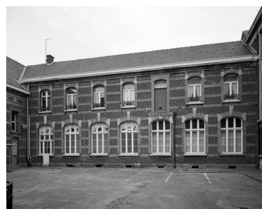
Bâtiment regroupant l'administration, les réfectoires et les services généraux, cour intérieure ouest, élévation du bâtiment fermant la cour du côté est, vue générale. Phot. Philippe Dapvril IVR31_20035900232V
