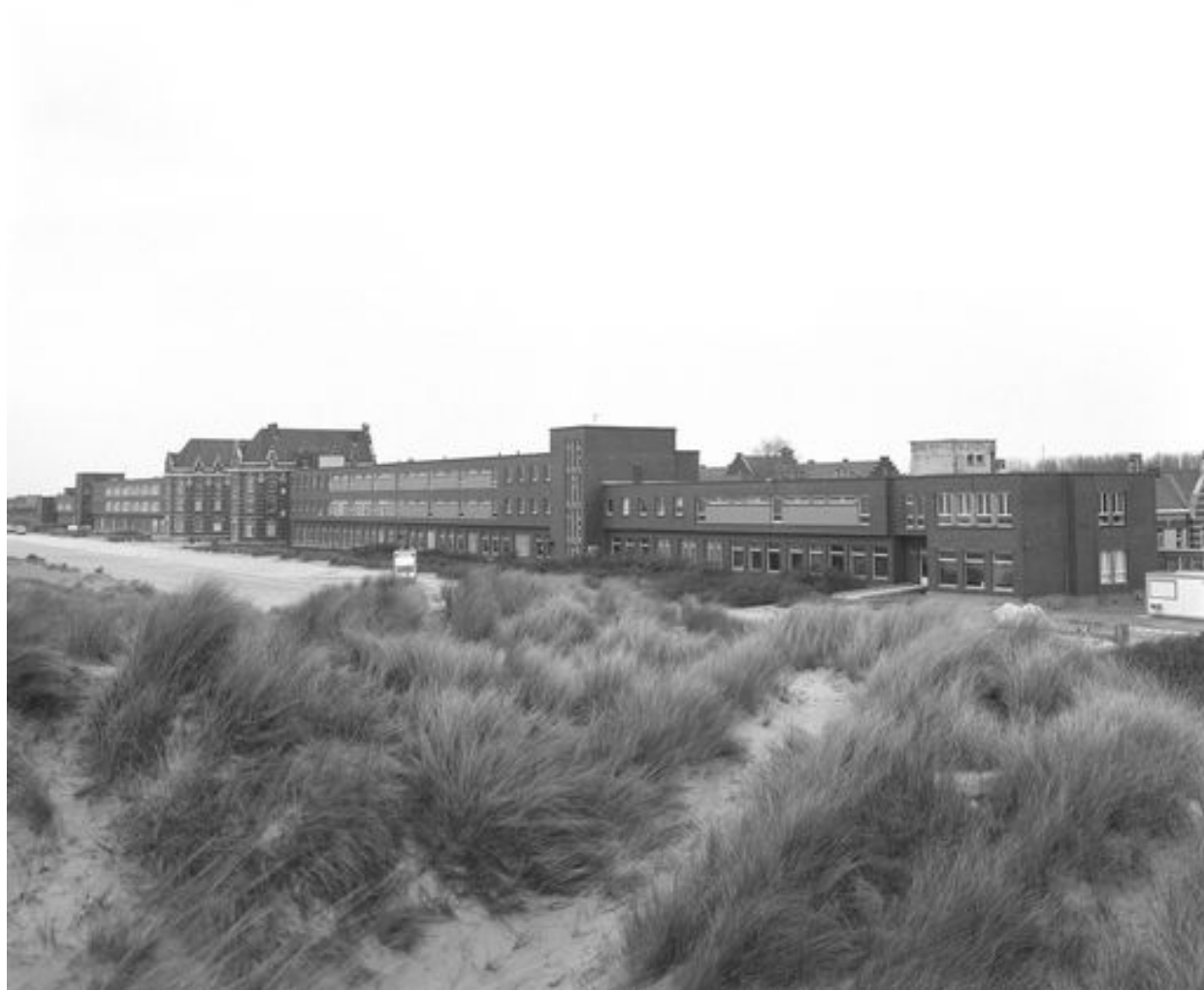
Bâtiment de 450 mètres de longueur dressé face à la mer, façade nord, vue générale prise de trois quarts droit.
