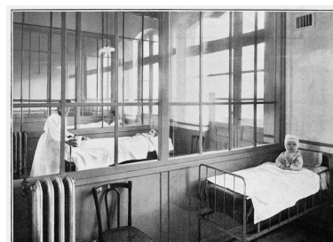
Un des pavillons d'isolement dits encore pavillons des contagieux, vue intérieure de détail montrant le système d'isolement individuel par boxage des salles au moyen de cloisons vitrées, photographie ancienne (archives de l'établissement). Repro. Philippe Dapvril IVR31_20035900213XB
