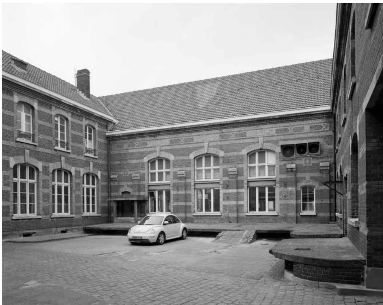
Bâtiment regroupant l'administration, les réfectoires et les services généraux, cour intérieure ouest, élévation du bâtiment, fermant la cour du côté nord, correspondant à l'un des réfectoires, vue générale.
