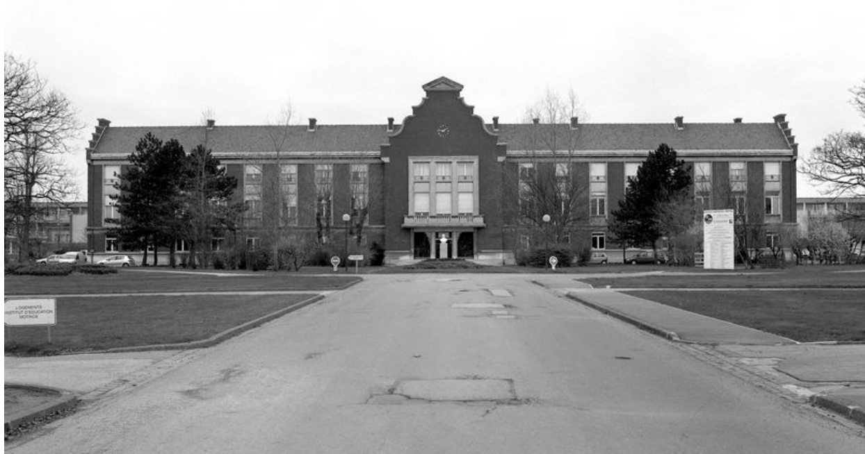
Bâtiment regroupant l'administration, les réfectoires et les services généraux, élévation antérieure, vue de face.
