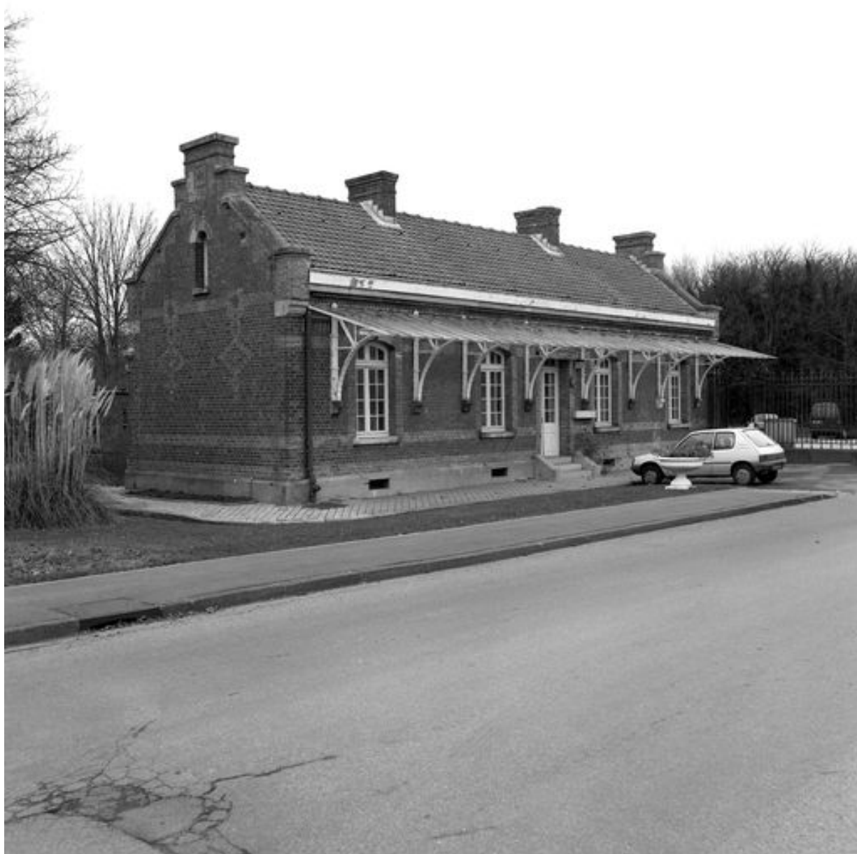
Pavillon d'entrée situé à droite en entrant, élévation antérieure, vue générale prise de trois quarts gauche.
