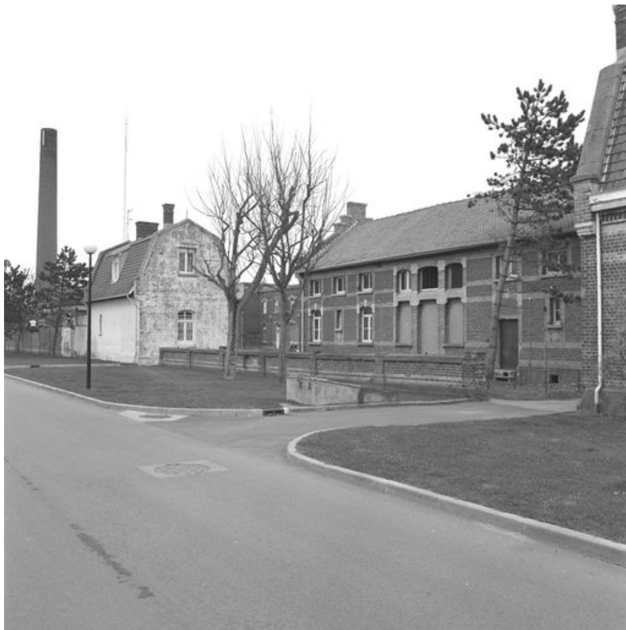
Bâtiment dit des machines, élévation nord prise de trois quarts droit avec, au second plan, l'élévation postérieure de l'habitation de l'aumônier.
