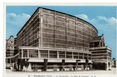
Salle de spectacle érigée au début des années 1930 sur l'emplacement de la celle qui avait été prévue dès l'origine, mais qui n'avait pas été réalisée, élévations ouest et sud, vue d'ensemble, carte postale, [ca 193?] (coll. part.) Repro. Eddy Stein IVR31_20065900746NUC2
