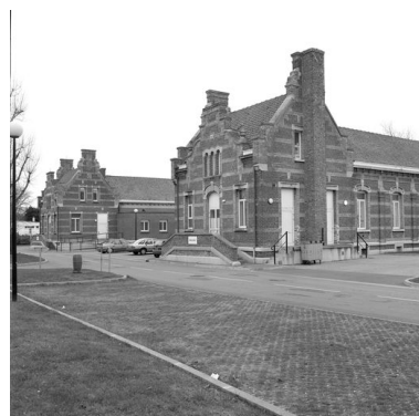
Pavillons des enfants valides, 1er et 2e pavillons de l'alignement du groupe ouest, désignés, en allant d'arrière en avant, par les lettres D et E, extrémités est, vue en enfilade prise du nord. Phot. Philippe Dapvril IVR31_20025902623X
