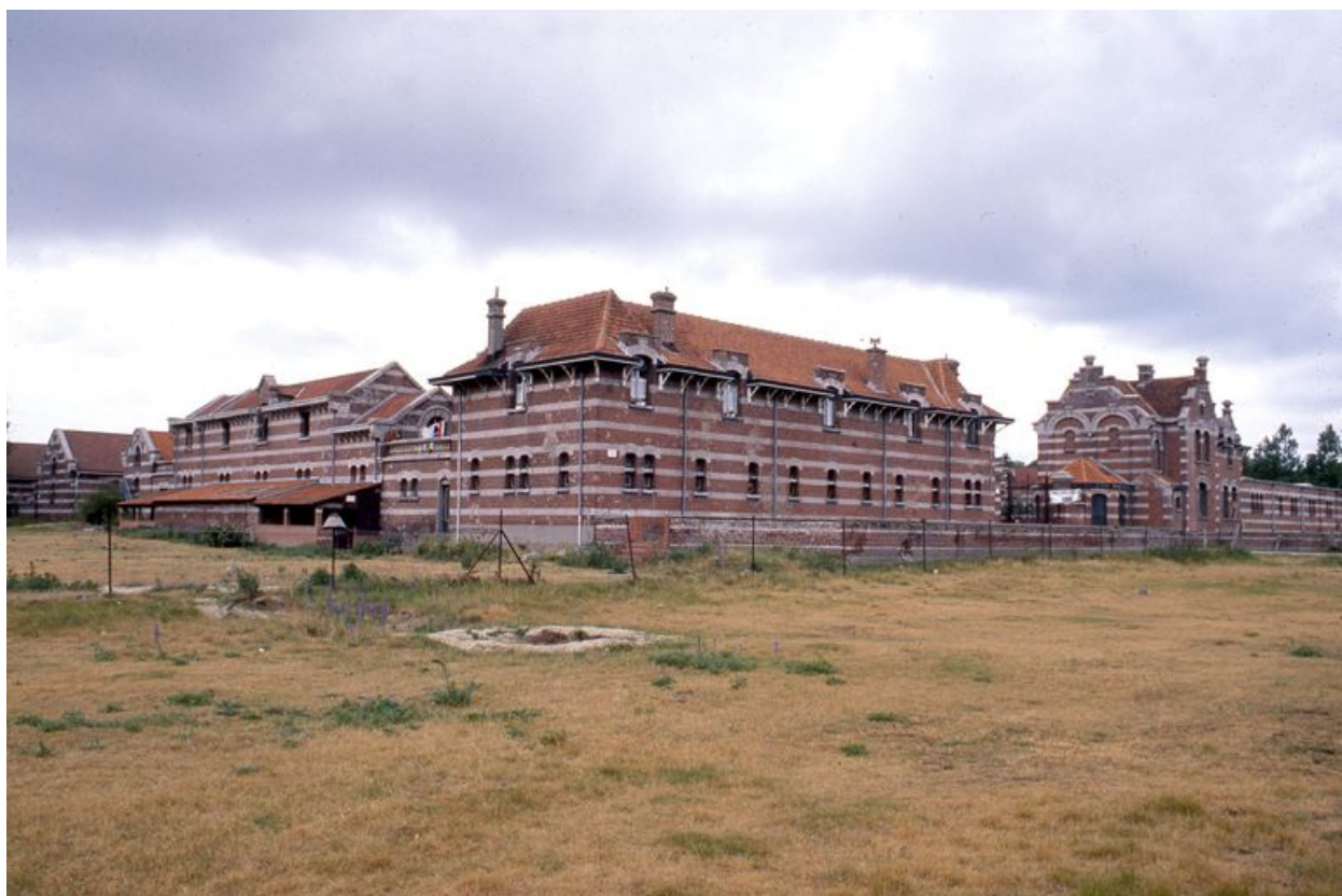
Ferme nord, bâtiments fermant la cour au sud et à l'est où se trouve l'entrée principale, élévations extérieures, vue d'ensemble.
