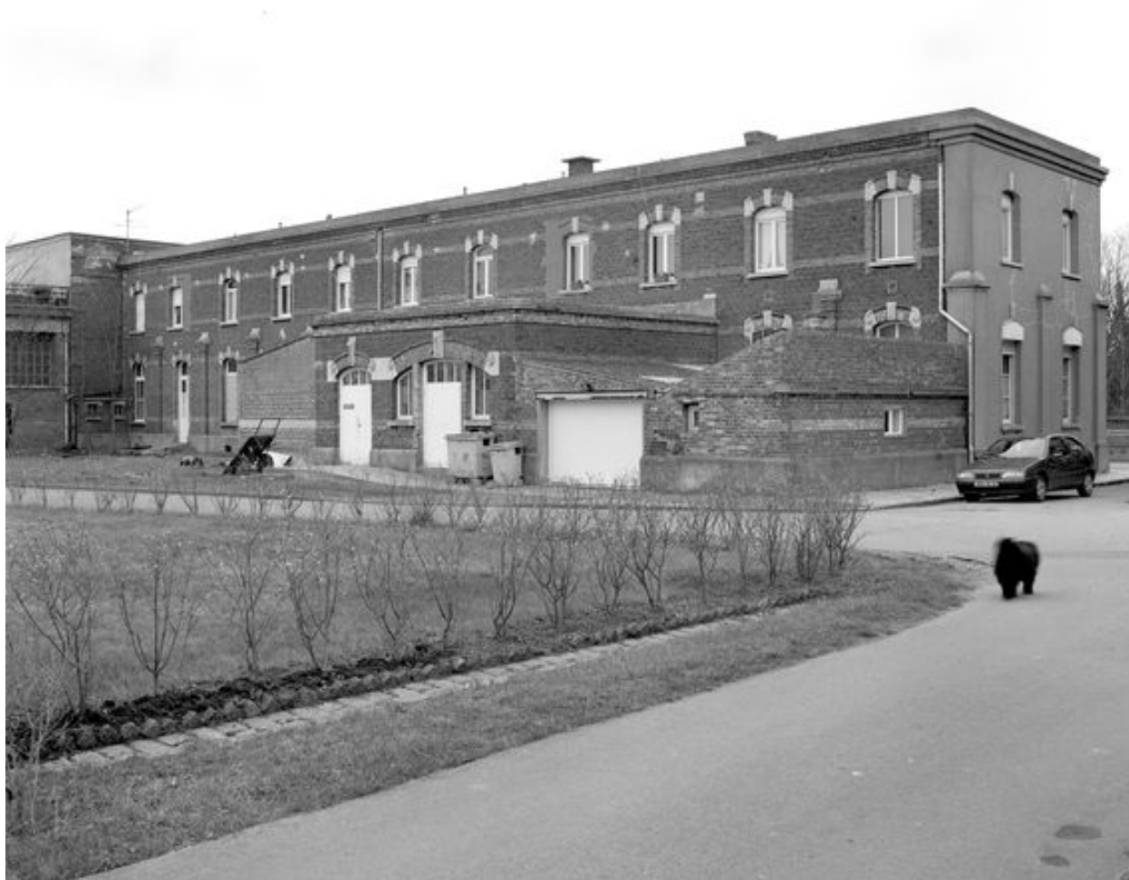
Bâtiment abritant la buanderie et les ateliers, avec des logements au 1er étage, élévation nord, vue de trois quarts droit.
