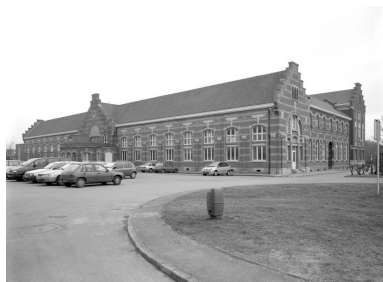
Bâtiment regroupant l'administration, les réfectoires et les services généraux, aile postérieure qui abrite les réfectoires et la cuisine, et aile latérale gauche, élévations sur jardin, vue d'ensemble.
