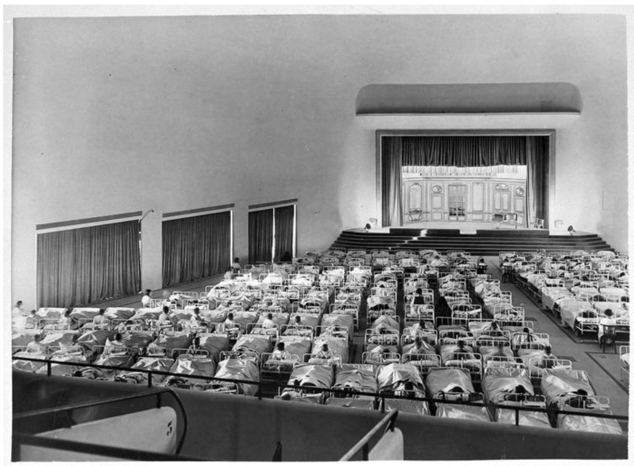
Salle des fêtes, vue intérieure générale en regardant vers la scène prise lors d'un spectacle, montrant la salle remplie par les lits des enfants invalides amenés depuis leurs dortoirs, photographie ancienne, années 1930 (archives de l'établissement).
