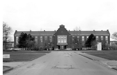
Bâtiment regroupant l'administration, les réfectoires et les services généraux, élévation antérieure, vue de face.
