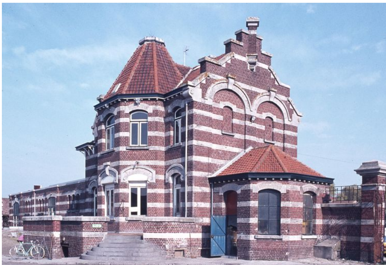
Ferme nord, bâtiments fermant la cour du côté est, détail de l'habitation du fermier, élévation sur la cour, vue de trois quarts droit.
