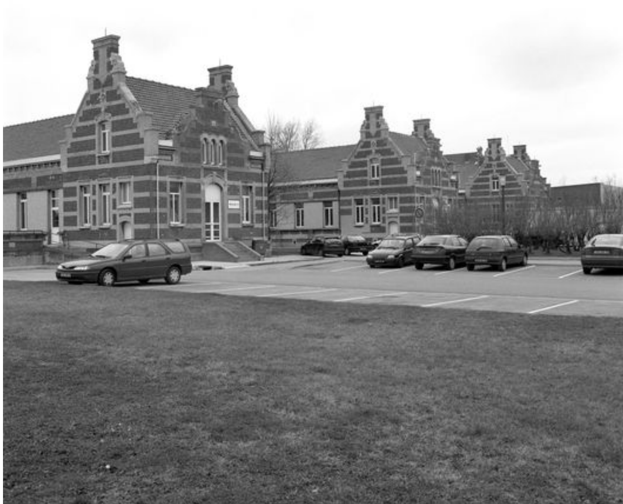
Pavillons des enfants invalides, trois derniers pavillons de l'alignement du groupe ouest, désignés, en allant d'arrière en avant, par les numéros 8, 9 et 10, vue d'ensemble prise de trois quarts gauche.
