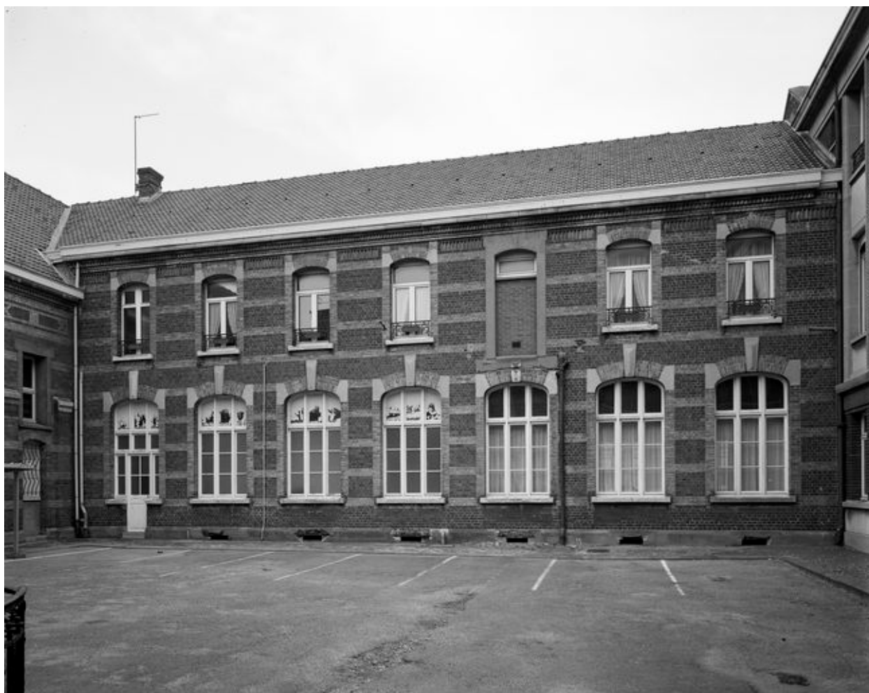
Bâtiment regroupant l'administration, les réfectoires et les services généraux, cour intérieure ouest, élévation du bâtiment fermant la cour du côté est, vue générale.
