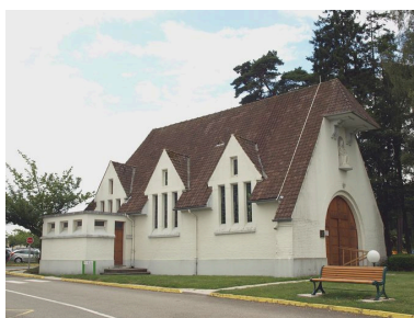
Chapelle, vue latérale Phot. Bruno Decrock IVR31_20106208251NUCA
