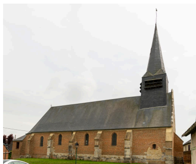
Vue générale depuis le nord. Phot. Marc Kérignard IVR32_20216000737NUCA
