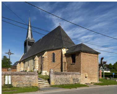
Vue générale depuis le sud-est. Phot. Marc Kérignard IVR32_20216000545NUCA
