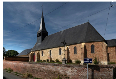
Vue générale depuis le sud-est. Phot. Marc Kérignard IVR32_20216000943NUCA
