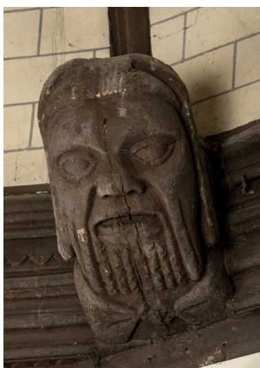
Blochet sculpté sur la poutre sablère : figure masculine. Phot. Marc Kérignard IVR32_20216000706NUCA
