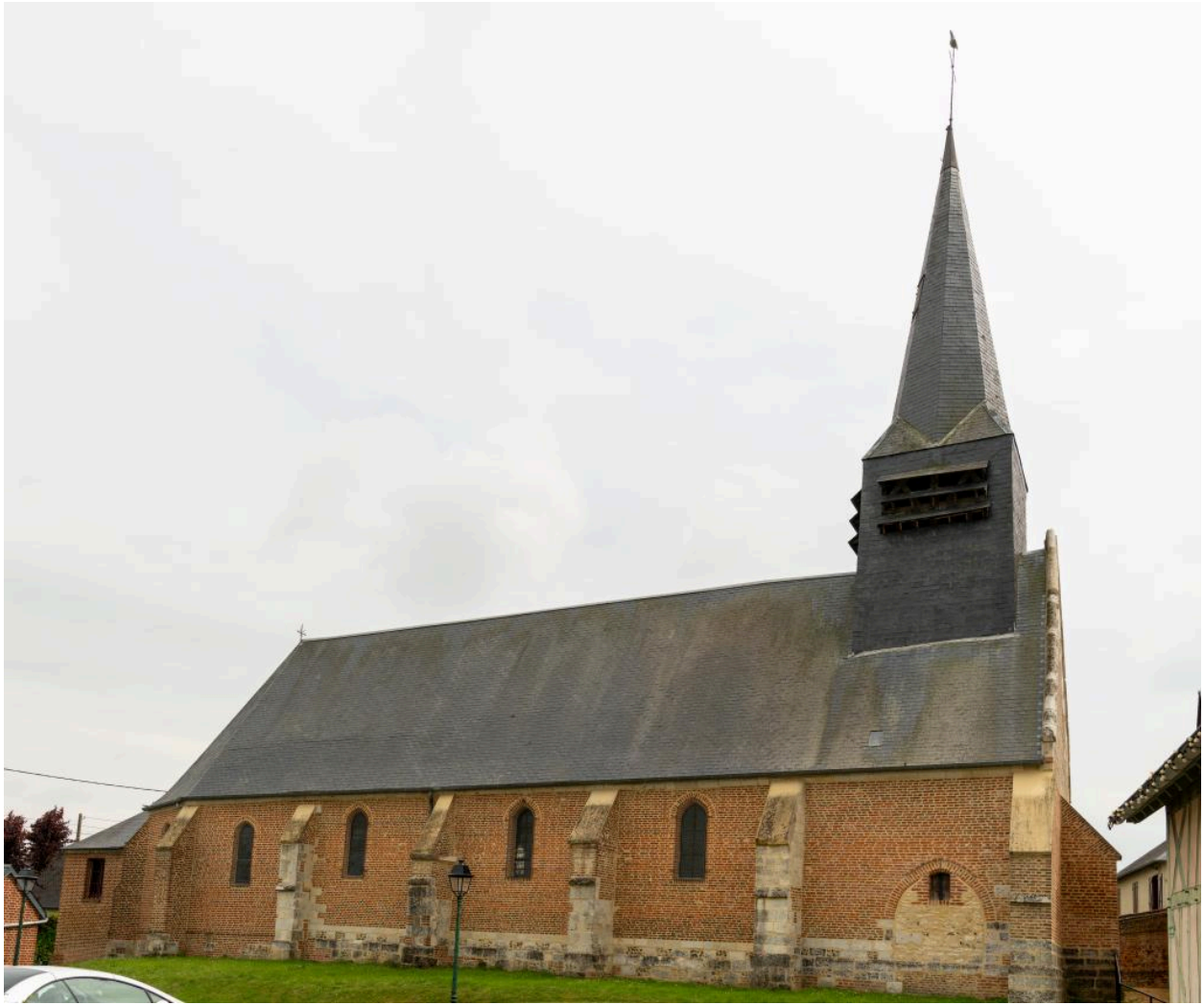
Vue générale depuis le nord.
