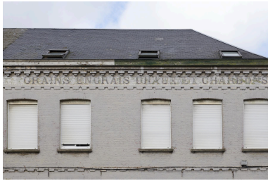
Détails des anciennes inscriptions de la façade sur rue. Phot. Delphine Volto Jourdan IVR32_20245903234NUCA
