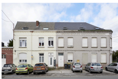
Façade sur rue. Phot. Delphine Volto Jourdan IVR32_20245903233NUCA
