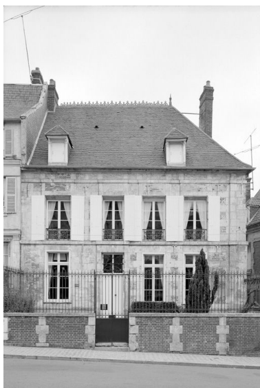
Vue générale. Phot. Fabrice Charrondière IVR22_19856001369X
