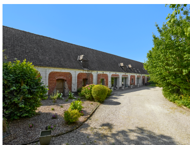
Vue nord du bâtiment sud, depuis la cour.
