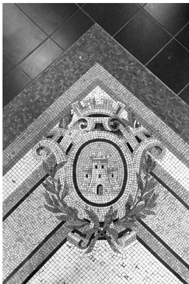
Détail de la mosaïque du vestibule : représentation des armes de Vervins. Phot. Pierre-Yves Brest IVR22_19990207308Z
