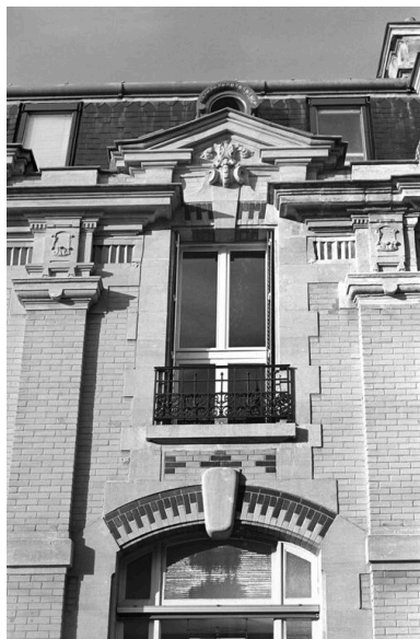
Détail d'une travée. Phot. Pierre-Yves Brest IVR22_19990207117Z
