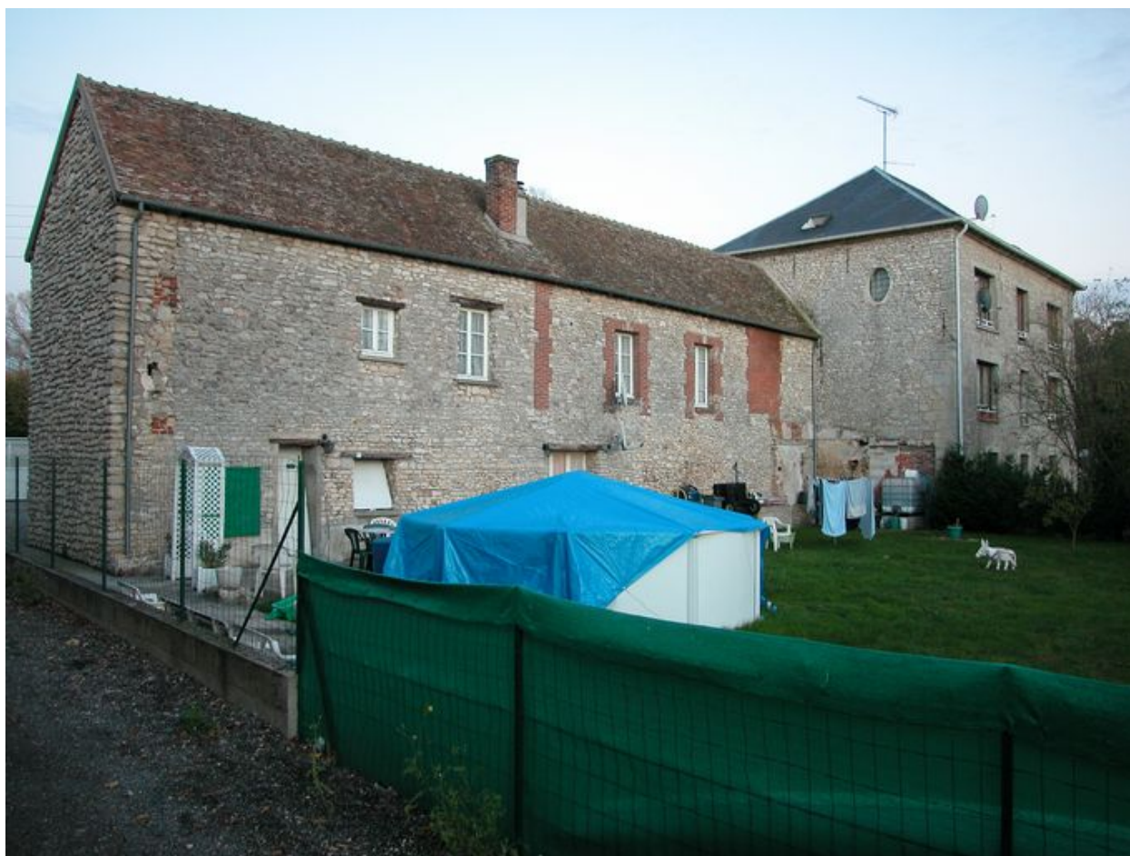
Vue d'ensemble postérieure.
