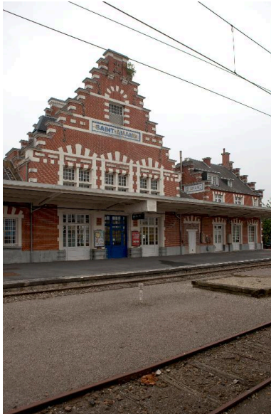
Vue générale de l'élévation postérieure. Phot. Pierre Thibaut IVR31_20125901756NUCA
