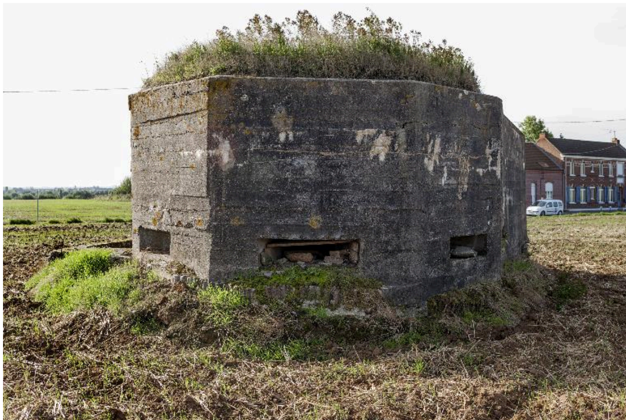
Vue de trois-quarts vers le sud-est
