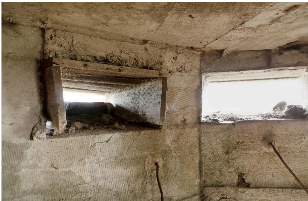
Détail de coffrage dans une des embrasures
