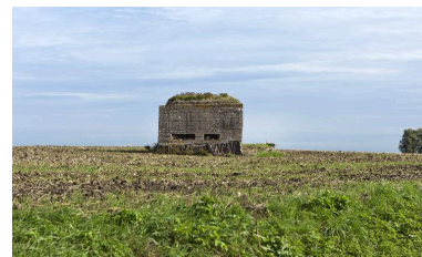
Elévation sud depuis la route Phot. Jean-Marc Ramette IVR31_20145905211NUCA
