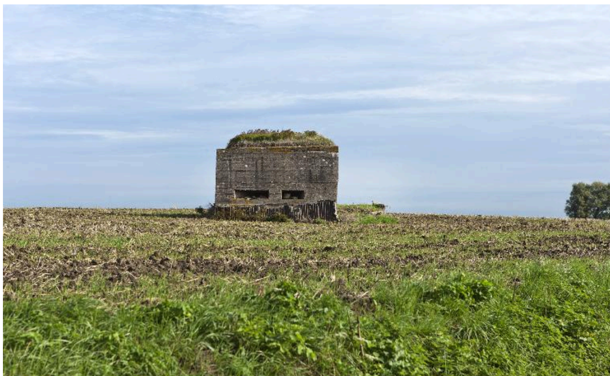
Elévation sud depuis la route
