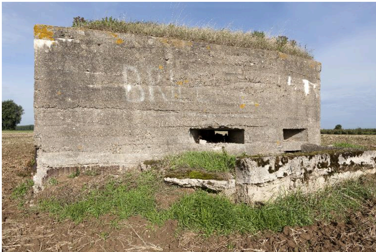
Elévation est. Au premier plan, l'accès à l'édifice
