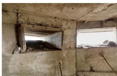
Détail de coffrage dans une des embrasures Phot. Jean-Marc Ramette IVR31_20145905221NUCA
