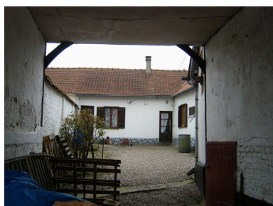
Vue du logis du n°18. Phot. Inès Guérin IVR22_20058005038NUCA
