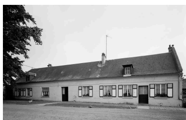
Logis. Elévation antérieure. Phot. Jean-Michel Périn IVR22_19856000826V
