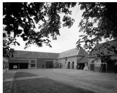
Bâtiments sur cour. Phot. Jean-Michel Périn IVR22_19856000825V
