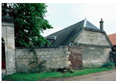
Grange. Pignon sur rue. Phot. Martine Plouvier IVR22_19856000926ZA
