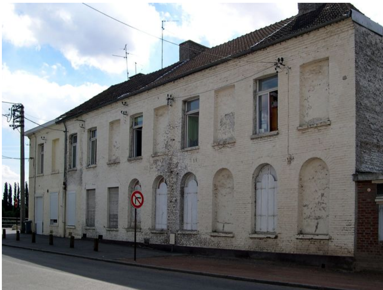
Maison n° 25 : aile en retour rue Molière.
