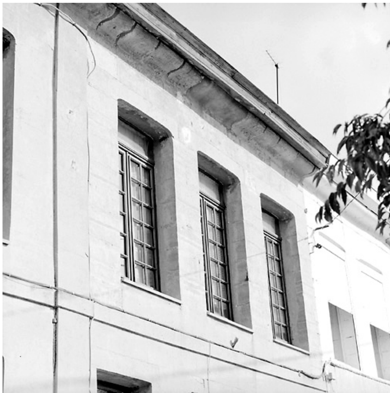
Maison n° 23 : vue partielle, étage, corniche.
