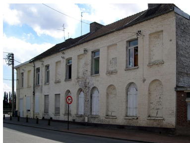
Maison n° 25 : aile en retour rue Molière. Phot. Anita Oger-Leurent IVR31_20065906228NUCA
