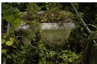
Vue de la jardinière. Phot. Thierry Lefébure IVR22_20058001289NUCA
