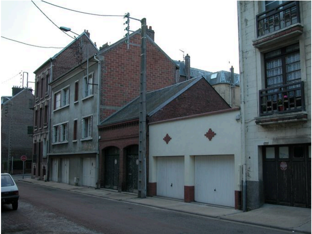
La rue Leboeuf, constructions de l'îlot 11, entre les rues Buzeaux et Julien-Hédin.
