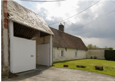
Entrée charretière et logis, n°6 Impasse des Vignes, vue depuis le nord-est. Phot. Marc Kérignard IVR32_20216000309NUCA
