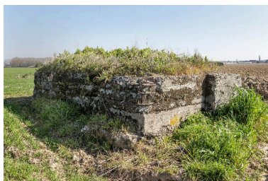
Vue de 3/4 arrière, vers le nord-est Phot. Jean-Marc Ramette IVR31_20145905026NUCA
