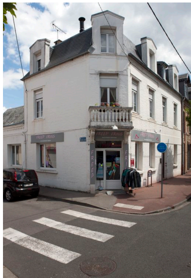
Vue générale. Phot. Pierre Thibaut IVR31_20146202196NUCA
