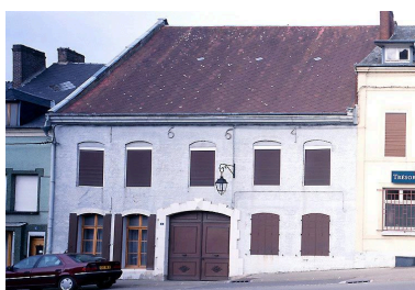
Façade sur rue. Phot. Franck Bürjes IVR22_19990200934XA
