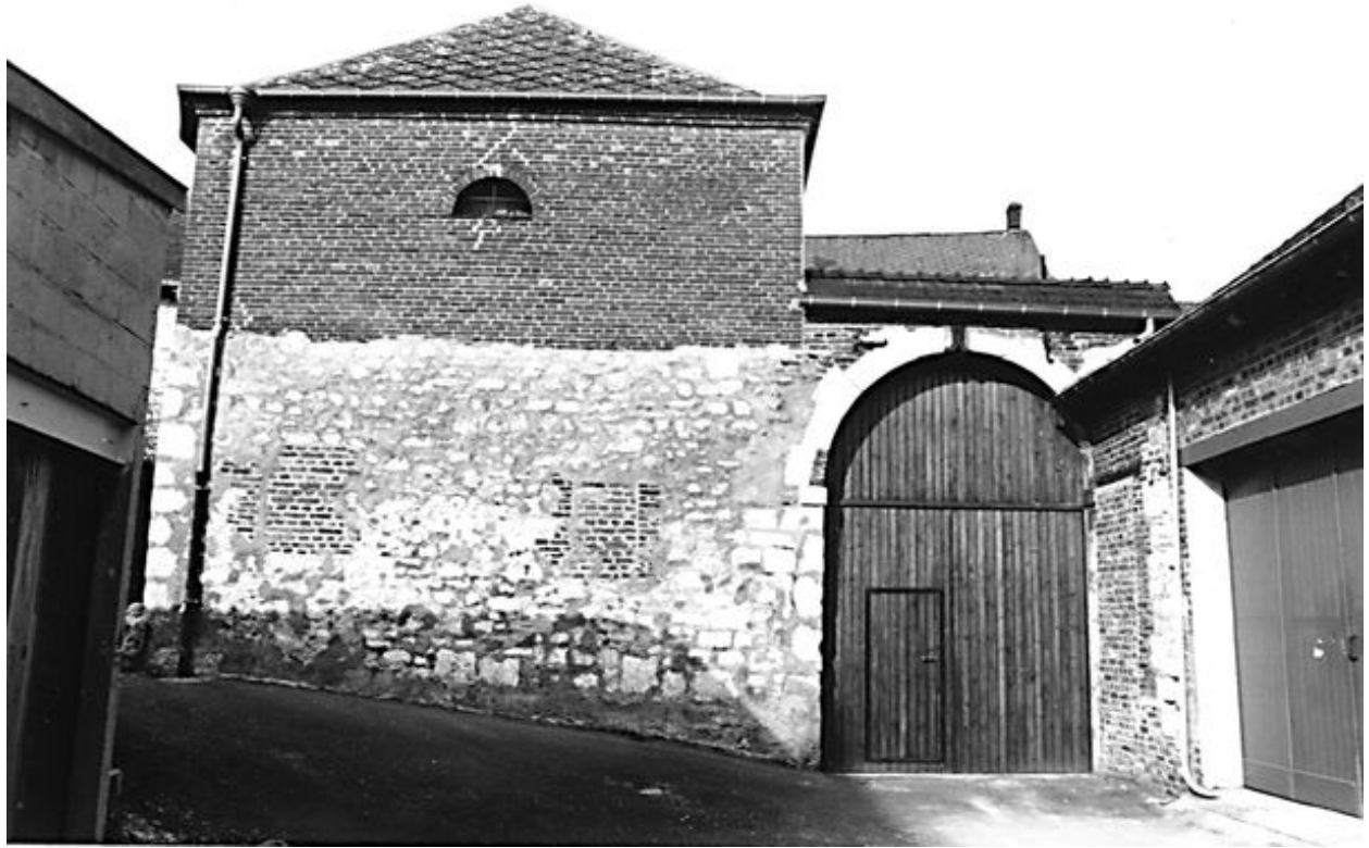
Pavillon à l'arrière de la cour et porche d'accès à la cour.
