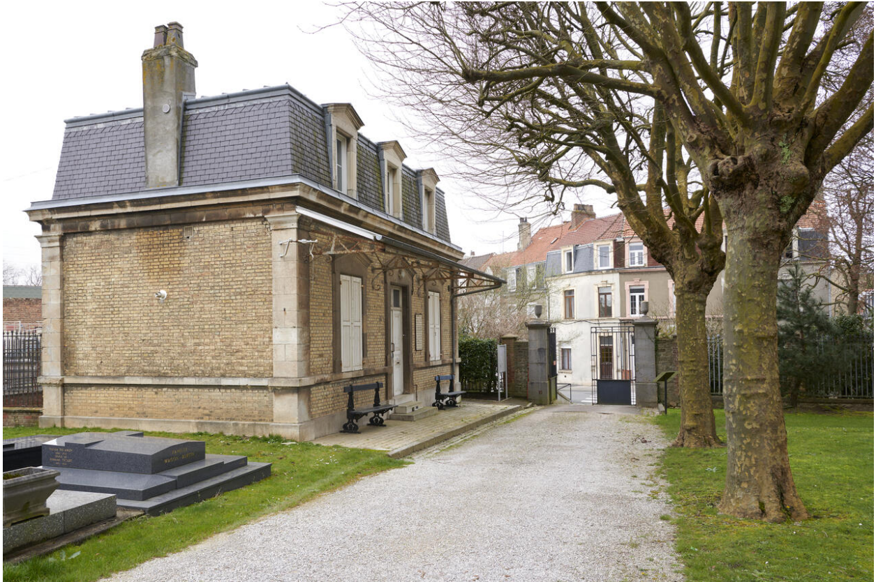
Vue vers l'entrée du cimetière rue Framery.
