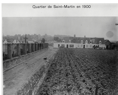
État en 1900. Photographie, 1900 (AC Boulogne-sur-Mer, clichés 1900). Repro. Eric Dessert IVR31_19806201922X
