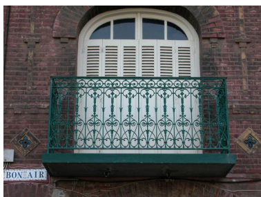
Détail du balcon en ferronnerie (maison de gauche, 1er étage carré).
