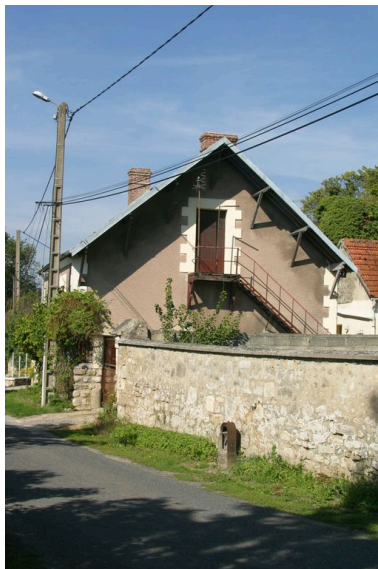
Vue du pignon droit. Phot. Inès Guérin IVR22_20030202006NUCA
