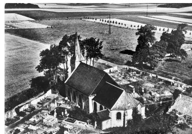
Vue aérienne de l'église, photo (coll. part.). Repro. Thierry Lefébure IVR32_20258002140NUCA
