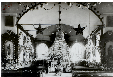
Intérieur de l'église, ancien aménagement liturgique, photo, 1937 (coll. part.). Repro. Thierry Lefébure IVR32_20258002111NUCA
