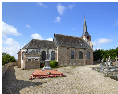
Vue d'ensemble de l'église, depuis le nord. Phot. Thierry Lefébure IVR32_20258001038NUCA
