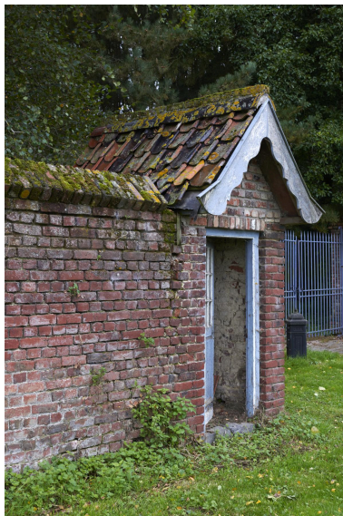
Profil gauche, la chapelle est intégrée à la clôture de la propriété. Phot. Delphine Volto Jourdan IVR32_20255900390NUCA
