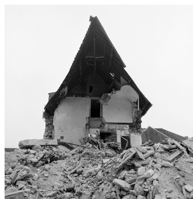
Bâtiment D, charpente. Phot. Philippe Dapvril IVR31_19886200683X
