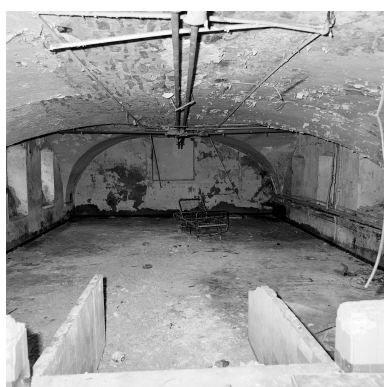
Bâtiment D, sous-sol, voûtement, vue de l'escalier. Phot. Philippe Dapvril IVR31_19886200673X
