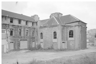
Bâtiment C, chapelle, vue d'ensemble nord rue du Vivier. Phot. Philippe Caudroit IVR31_19846200144X
