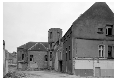
Bâtiment C, chapelle : vue d'ensemble ouest. Phot. Philippe Caudroit IVR31_19846200121X
