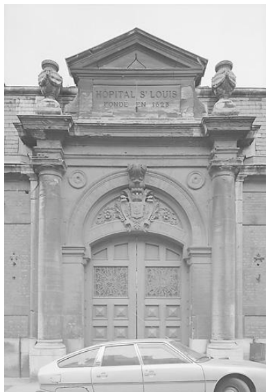
Bâtiment A, portail d'entrée, façade sur voie. Phot. Philippe Caudroit IVR31_19846200161X
