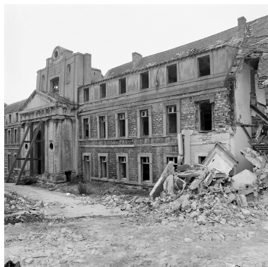
Bâtiment C, chapelle, vue d'ensemble sur cour. Phot. Philippe Dapvril IVR31_19886200676X
