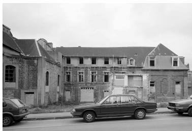
Bâtiment C, partie est, façade partielle rue du Vivier. Phot. Philippe Caudroit IVR31_19846200143X
