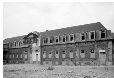
Bâtiment B, façade est sur cour. Phot. Philippe Caudroit IVR31_19846200123X
