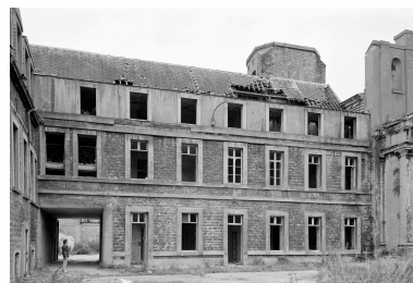
Bâtiment C, partie ouest, façade sur cour. Phot. Philippe Dapvril IVR31_19886200651X
