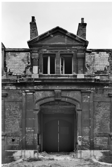
Bâtiment A, portail d'entrée, façade sur cour. Phot. Philippe Dapvril IVR31_19886200660X
