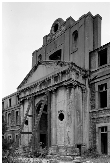
Chapelle, entrée : vue d'angle sur cour. Phot. Philippe Dapvril IVR31_19886200658X
