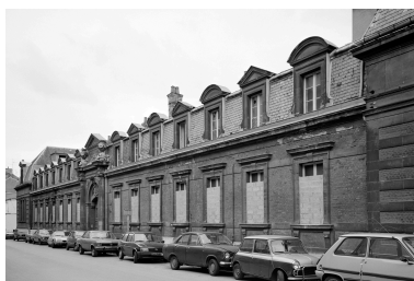
Bâtiment A, corps central, façade sur rue Saint-Louis. Phot. Philippe Caudroit IVR31_19846200166X
