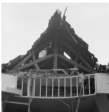
Bâtiment B, charpente. Phot. Philippe Dapvril IVR31_19886200682X
