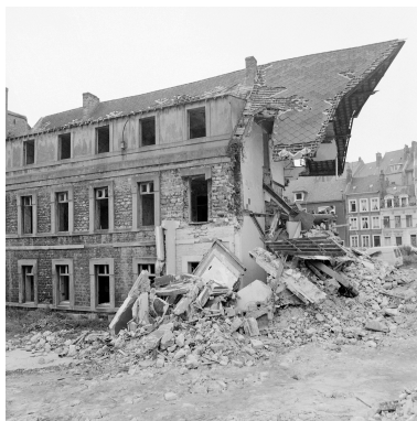
Bâtiment C, façade sur cour, partie nord. Phot. Philippe Dapvril IVR31_19886200666X
