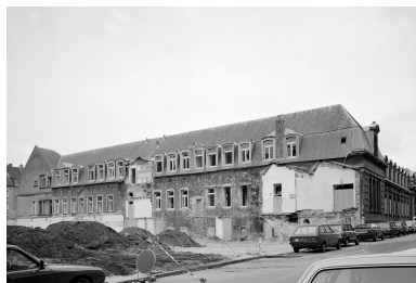
Bâtiment D, vue d'angle de la rue Saint-Louis. Phot. Philippe Caudroit IVR31_19846200162X
