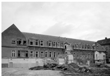
Bâtiment D, façade ouest. Phot. Philippe Caudroit IVR31_19846200124X
