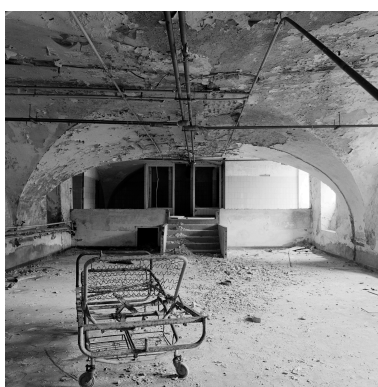
Bâtiment D, sous-sol, voûtement, vue vers l'escalier. Phot. Philippe Dapvril IVR31_19886200686X
