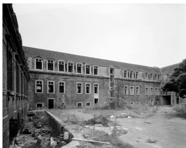
Bâtiment D, façade sur cour. Phot. Philippe Dapvril IVR31_19886200646V
