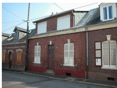
Maison (44 rue Parmentier) portant une plaque émaillée 'eau de source analysée et autorisée'. Phot. Elisabeth Justome IVR22_20058003136NUCA
