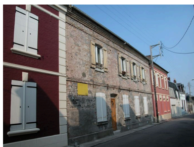
Maison, 11 rue Boyard (1988 BE 278), porte la date 1842. Phot. Elisabeth Justome IVR22_20058003651NUCA
