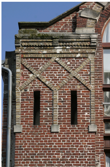
Maçonnerie des ateliers : détail. Phot. Frédéric Pillet IVR22_20050206182NUCA
