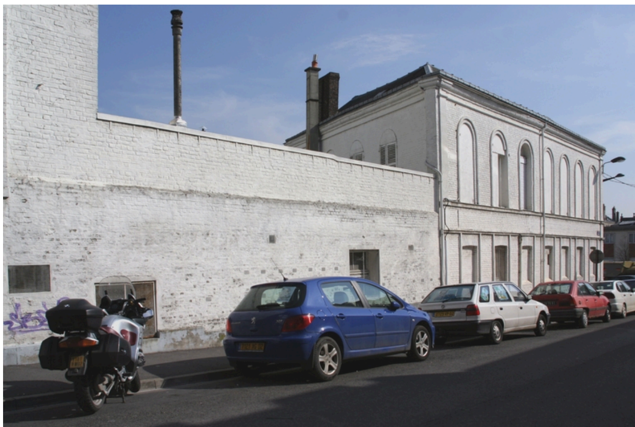
Façade postérieure, rue Michelet.
