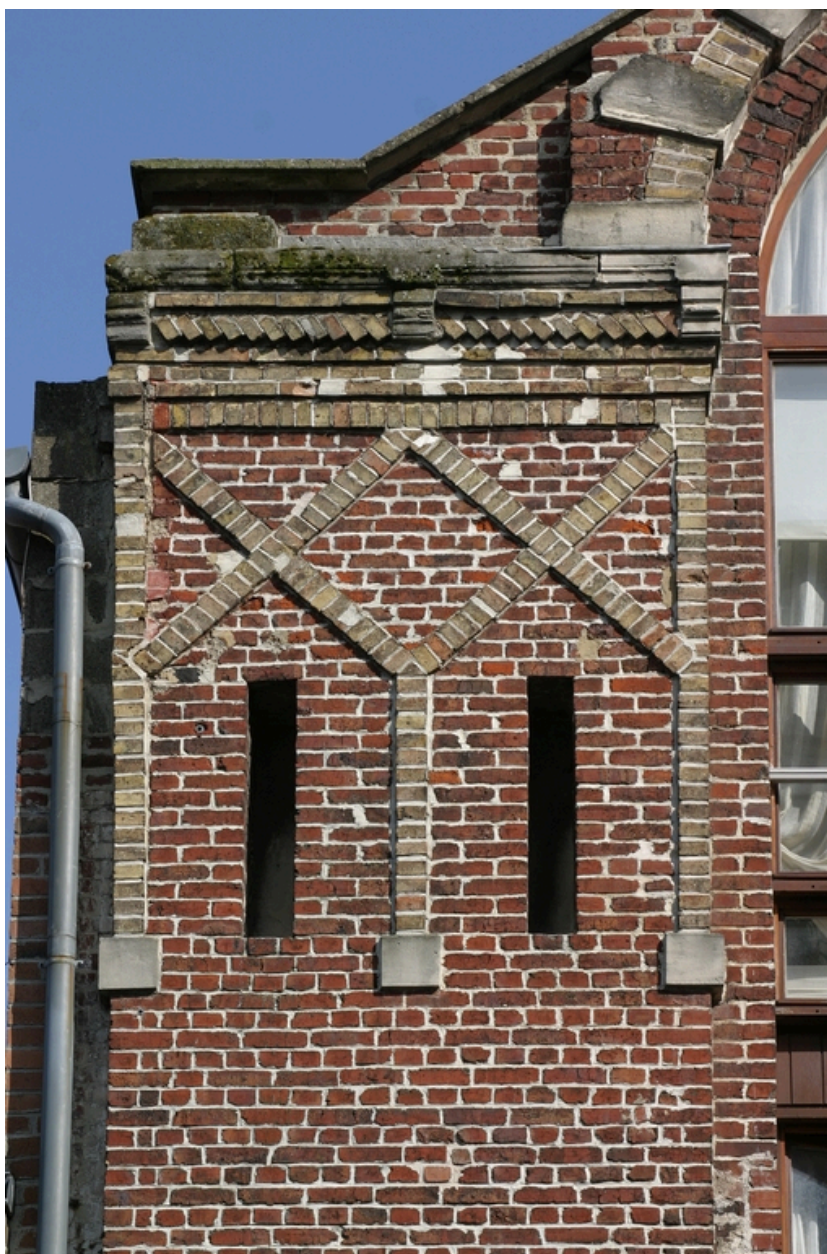
Maçonnerie des ateliers : détail.
