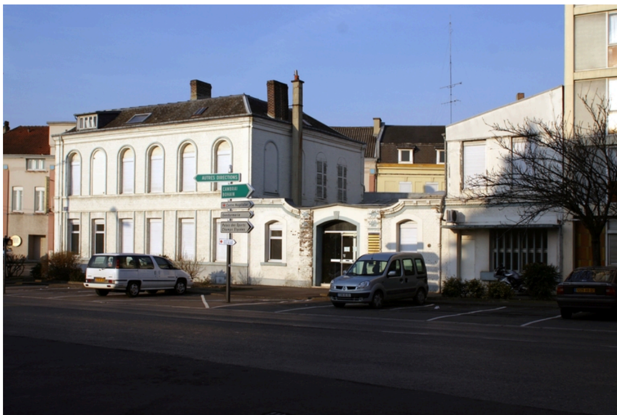
Façade antérieure, boulevard Gambetta.
