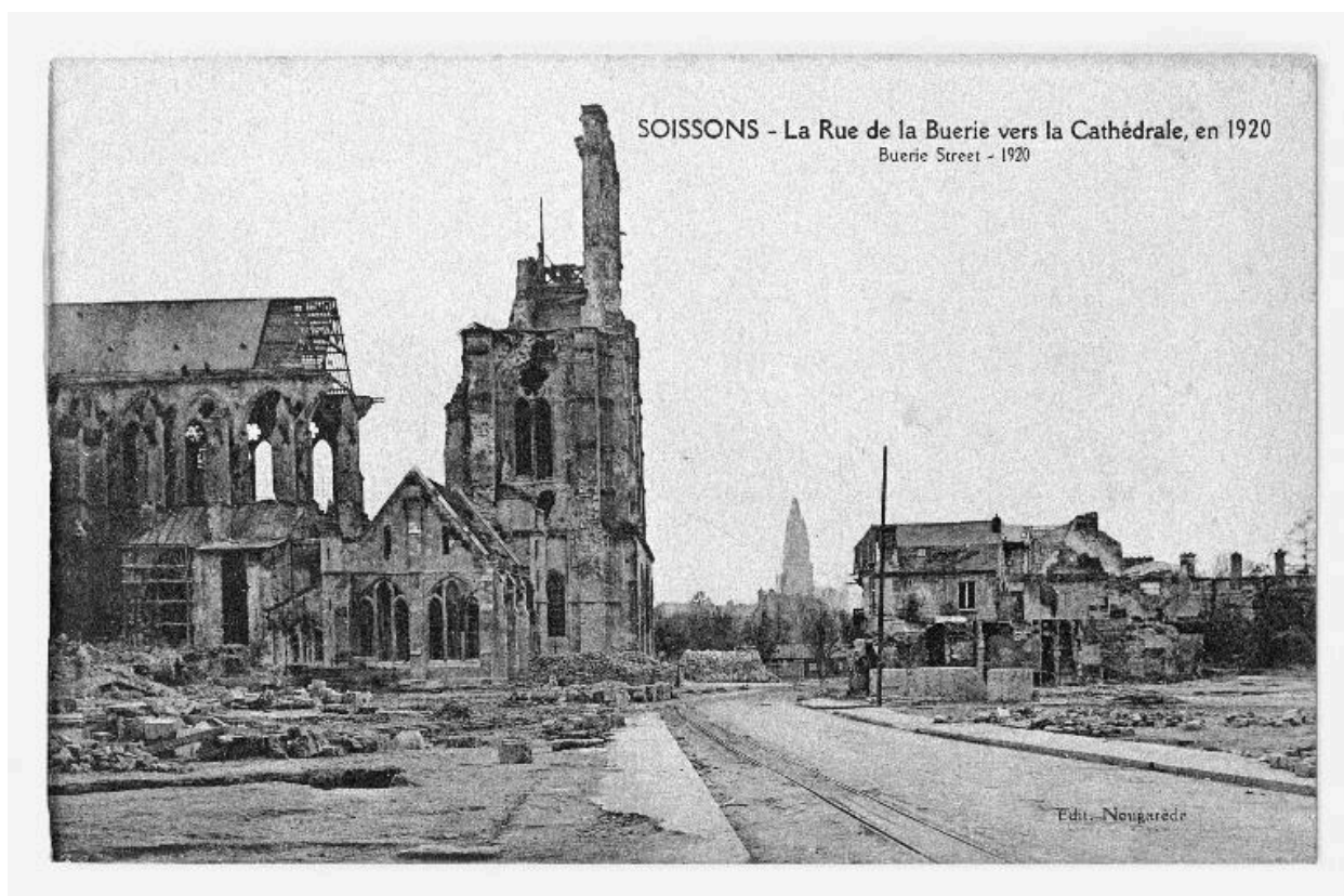
Vue des îlots situés au nord et à l'ouest de la cathédrale, vers 1920 (A Évêché Soissons : 4 Y, Soissons-Cathédrale).
