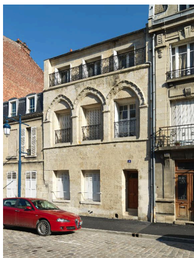
Façade de l'ancienne maison, dite "de la Chartre" (tribunal et prisons du chapitre). Phot. Thierry Lefébure IVR22_20130200098NUC2A
