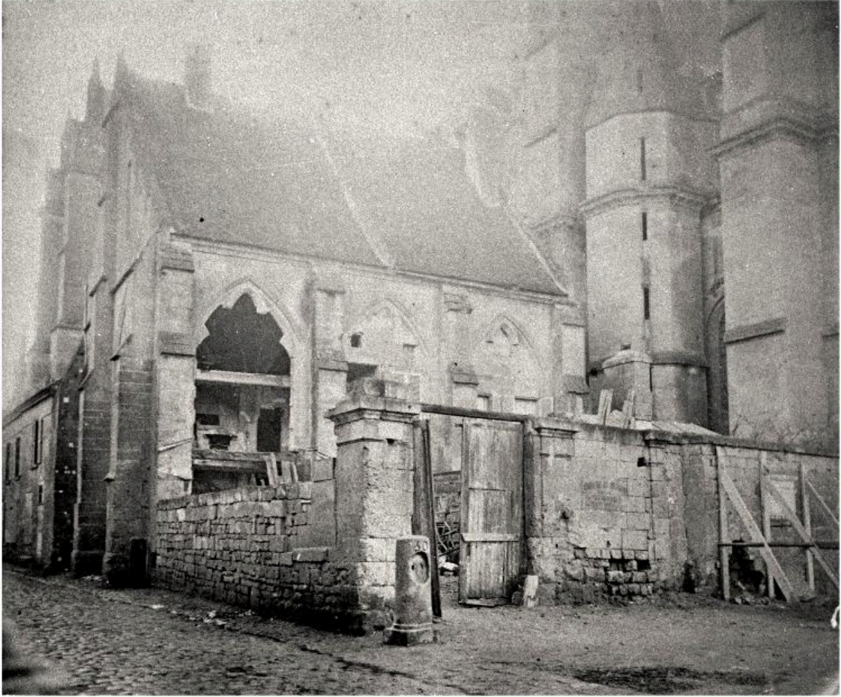
Vue nord-ouest de l'ancienne salle capitulaire, vers 1875 (A Évêché Soissons : 2 Y, Soissons-Cathédrale).
