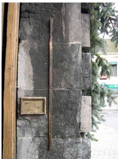
Vue générale. Phot. Anita Oger-Leurent IVR31_20065906097NUCA
