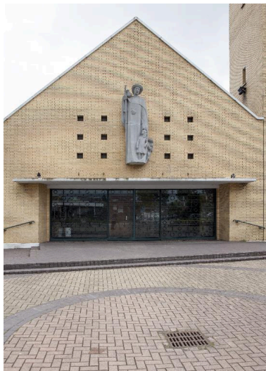
Élévation antérieure de l'église. Phot. Pierre Thibaut IVR31_20155900406NUCA
