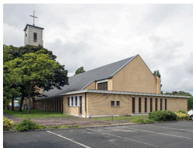
Élévation postérieur et flanc droit de l'église. Phot. Pierre Thibaut IVR31_20155900403NUCA
