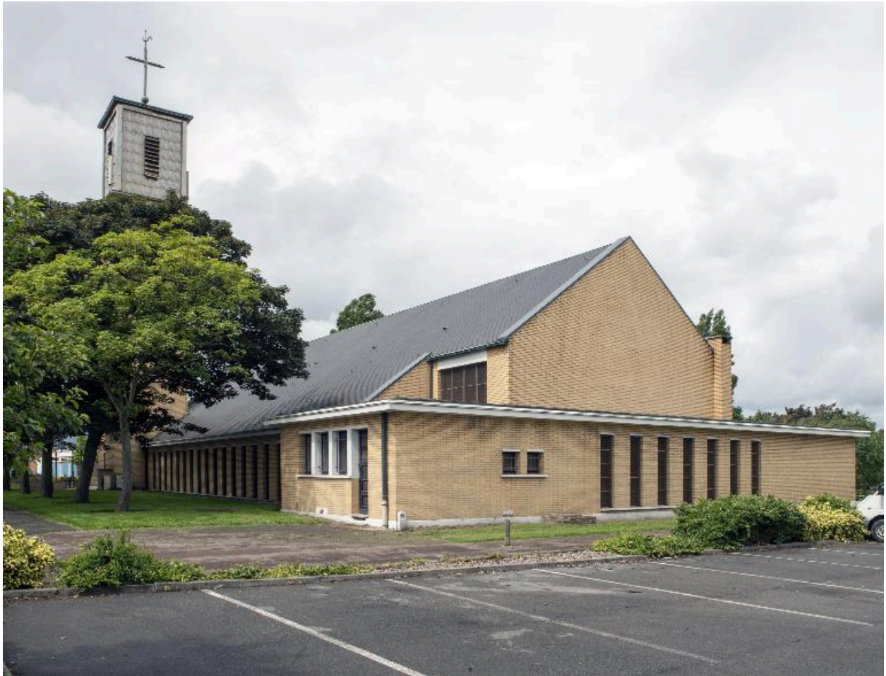
Élévation postérieur et flanc droit de l'église.
